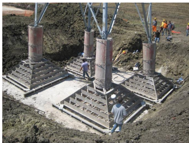
Foto 1: Area di microcantiere tipo per l'installazione delle fondazioni di un sostegno 150 kV
