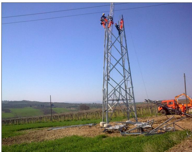
Foto 2: Area di microcantiere durante la realizzazione del sostegno
