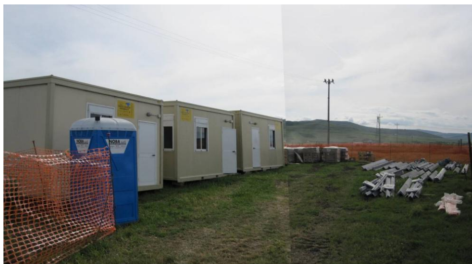
Figura 13 - esempio di area centrale di cantiere
