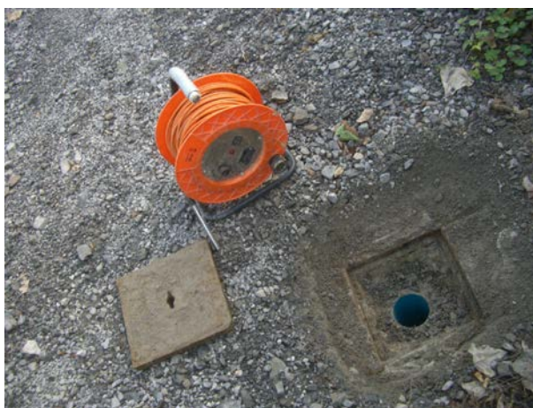
MONITORAGGIO DEL LIVELLO DI FALDA Piezometro A SOT_21
