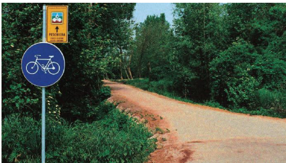
Figura 7 Pista in terra stabilizzata
