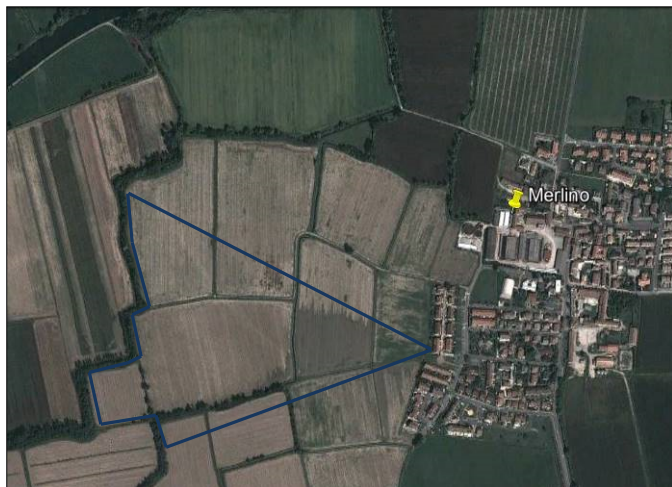
Figura 19 – Situazione ante operam
