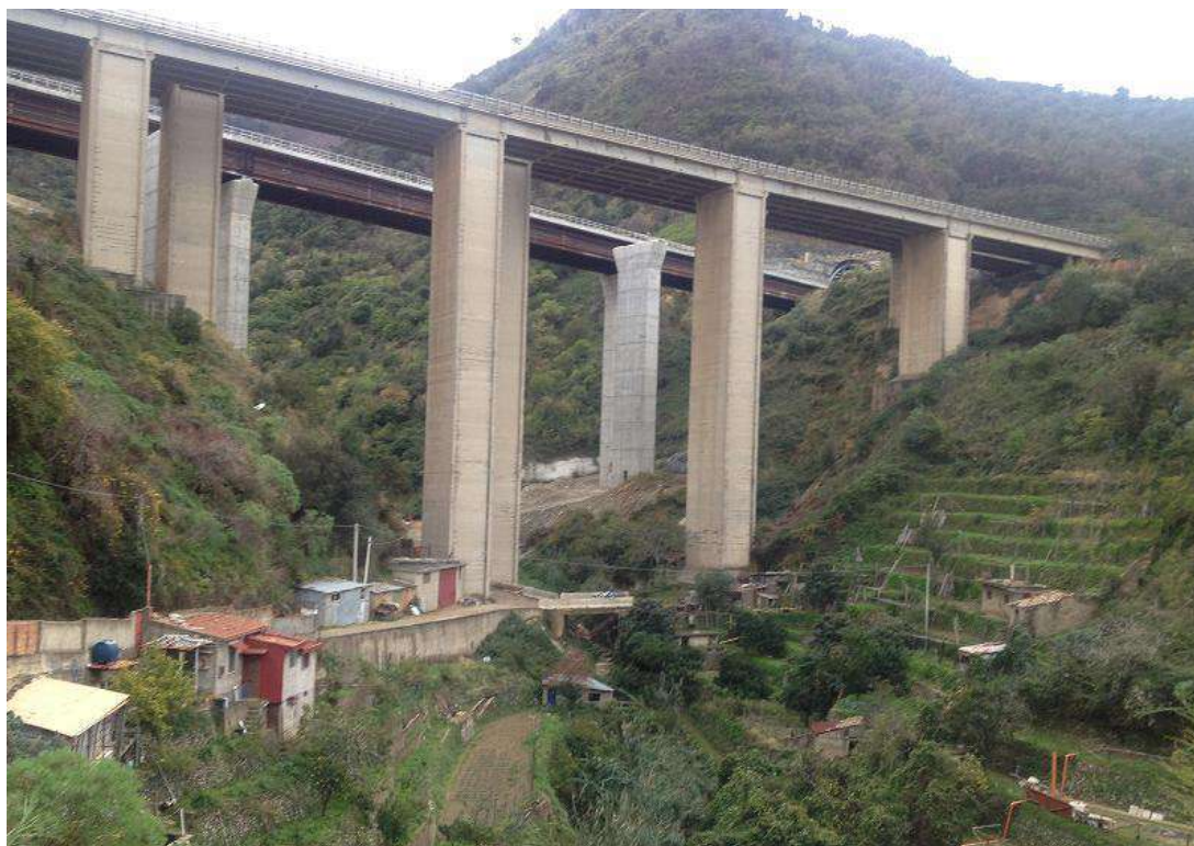
Figura 10: Panoramica del versante che delimita il Vallone Livorno in sinistra orografica.
