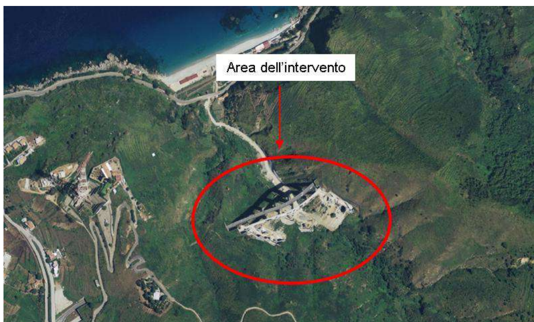
Figura 27: Area di intervento Viadotto San Gregorio
