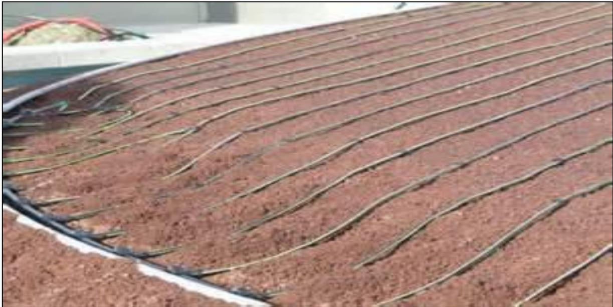
*Figura 3: Impianto di subirrigazione in costruzione*
