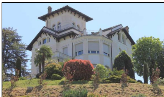
Figura 28 - Edificio lungo via Moriassi
