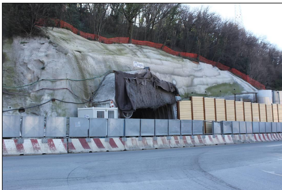
Figura 30 - Finestra Borzoli e barriere stradali
