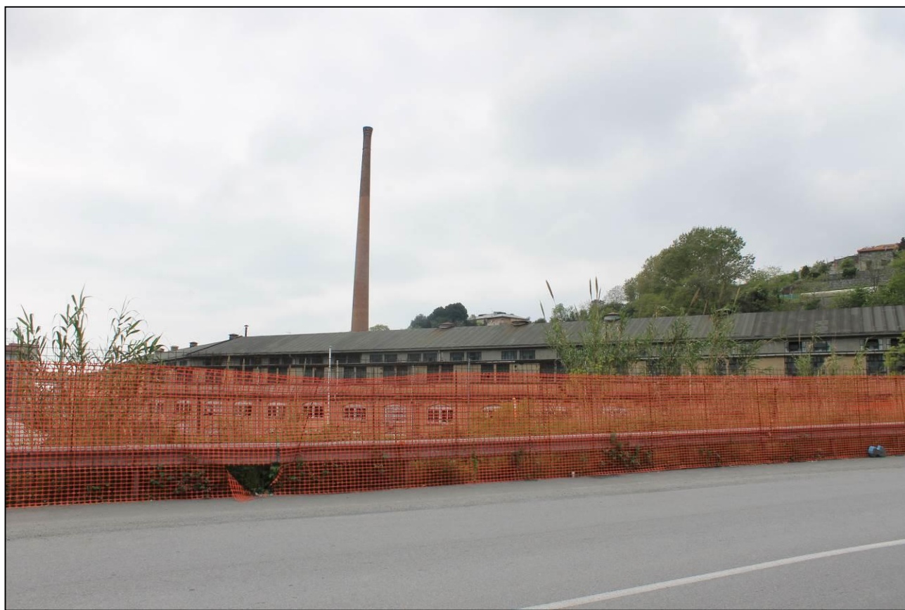
Figura 61 - Area industriale dismessa
