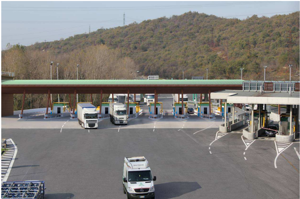
Render dell'ipotesi della nuova pensilina costituita da un rivestimento in "tecu" verde per la parte superiore ed un rivestimento in acciaio "corten" per la parte inferiore
