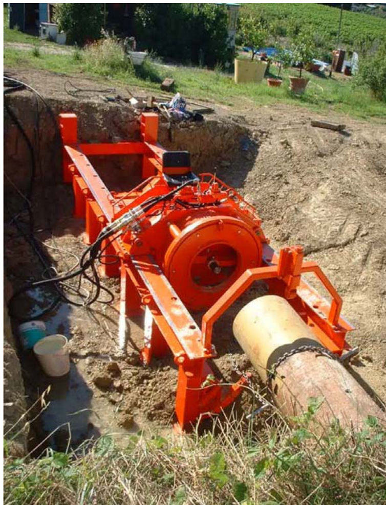
Slika 8.h: Primer vrtalnika za polaganje kablov
