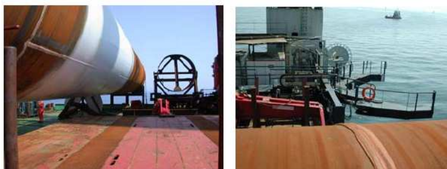
Figura 4.23 – Dima di inclinazione e posizionamento installate sul pontone.
