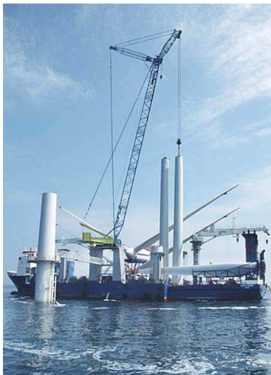
Figura 4.27 – Installazione della Turbina: montaggio dei conchi di torre.
