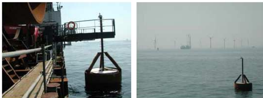
Figura 4.25 – Faro di segnalazione temporaneo installato sul palo di fondazione appena installato.
