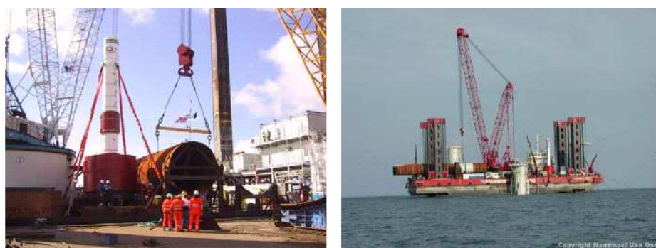
Figura 4.22 – Operazioni portuali di carico dei pali di fondazione sul pontone.
