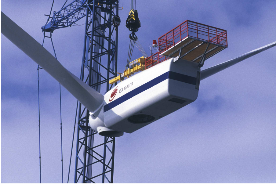
Figura 4.28 – Installazione della Turbina: sollevamento della navicella e del rotore.
