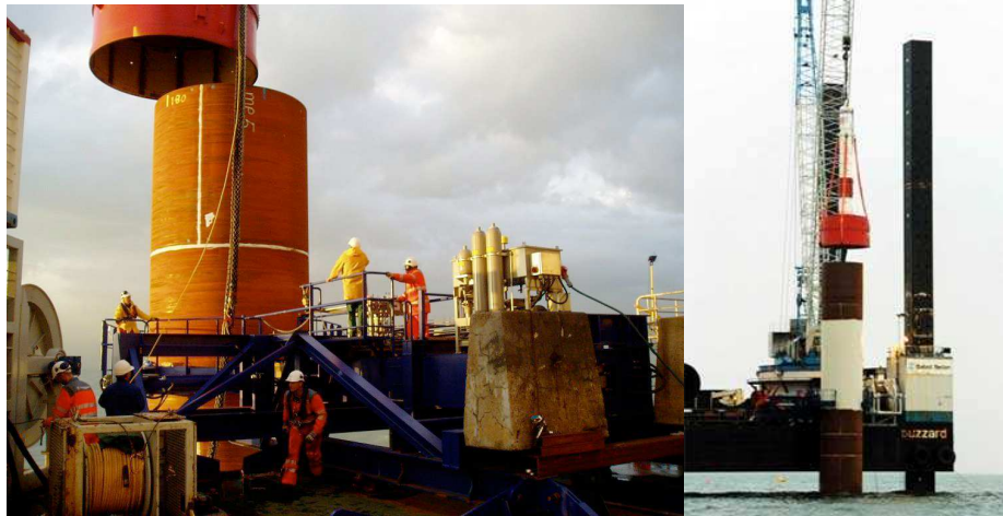
Figura 4.24 – Fase di sollevamento del maglio e successivo posizionamento in corrispondenza del palo.
