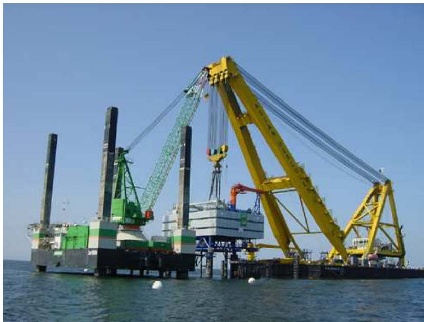
Figura 4.31 – Installazione della Stazione di trasformazione a mare: operazioni di sollevamento componenti.
