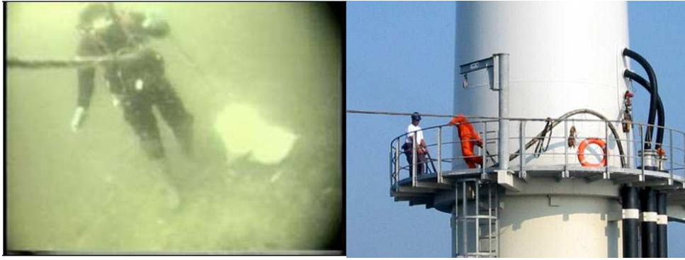
Figura 4.32 – Posa dei cavi sottomarini: Inserimento del cavo nel tubo a J.
