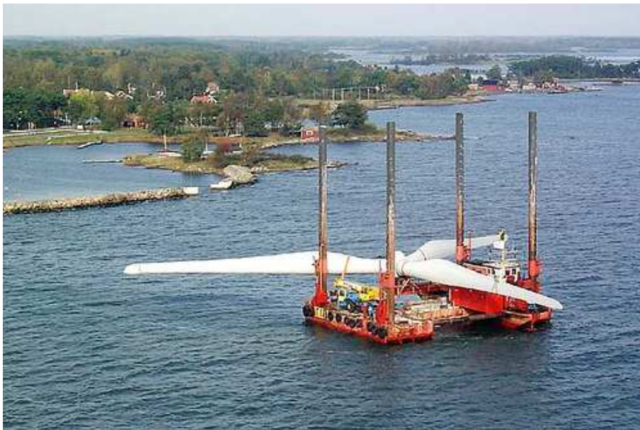
Figura 4.29 – Installazione della Turbina: trasporto del rotore pre-assemblato a terra.
