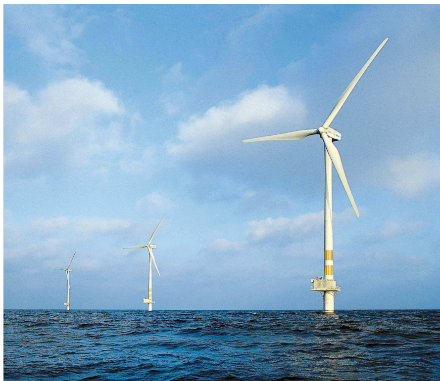
Figura 4.6 – Esempio di turbina eolica da 3,0 MW installata in mare.
