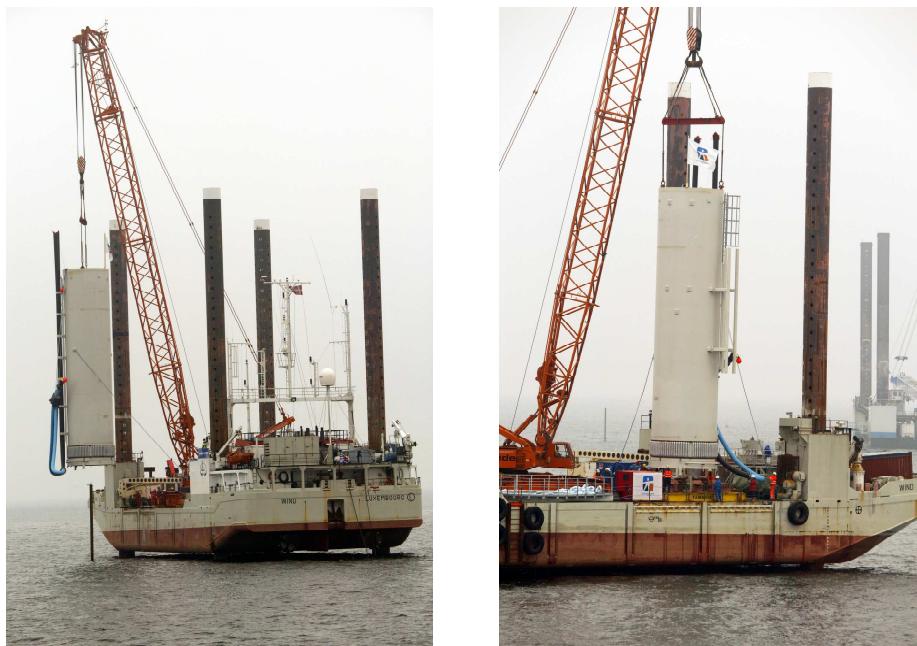
Figura 4.26 – Faro di segnalazione temporaneo installato sul palo di fondazione appena installato.
