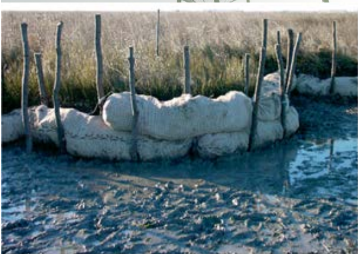
Figura 3-6 Buzzi in cocco ai margini della canaletta Laghi (sopra). Buzzi con ramaglie (sotto), al momento della realizzazione 2001 (Magistrato alle Acque - CVN-SI, 2008).
