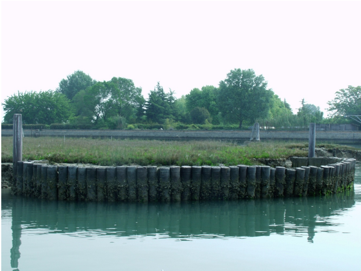
Figura 3-2 Pali in plastica a protezione di un tratto di margine della barena naturale Tresso a 5 anni dall'infissione (Magistrato alle Acque - CVN-SI, 2008).
