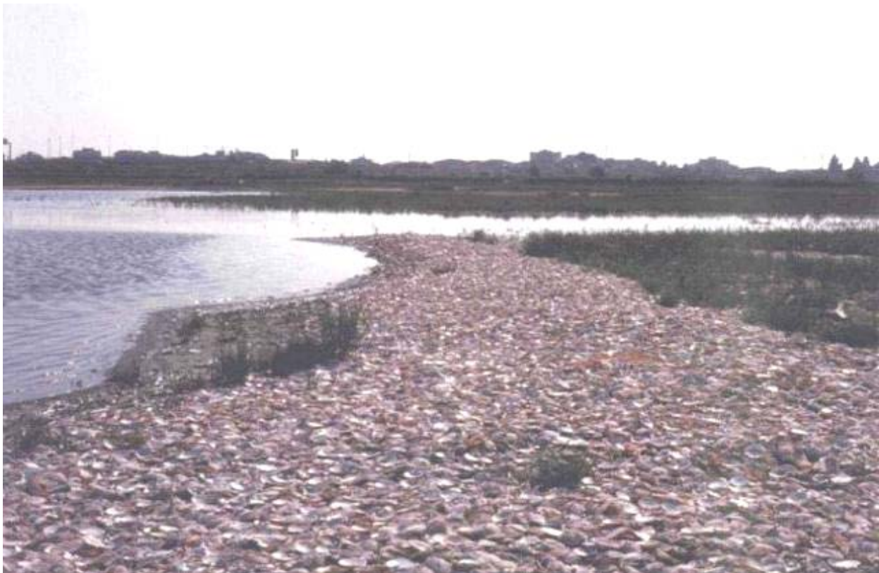
Figura 3-7 Foto di un intervento di protezione del margine con accumuli di conchiglie (Magistrato alle Acque - Technital, 2004).
