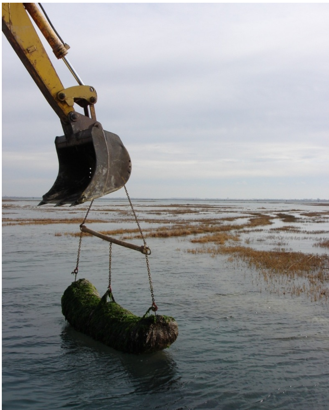
Figura 3-5 Operazione di rimozione delle burghe lungo il canale di Burano (Magistrato alle Acque - CVN-SI, 2008).
