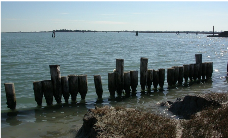
Figura 3-1 Palificata degradata dall'azione delle teredini, che perforano e penetrano in senso longitudinale all'interno del palo (Magistrato alle Acque - CVN-SI, 2008).
