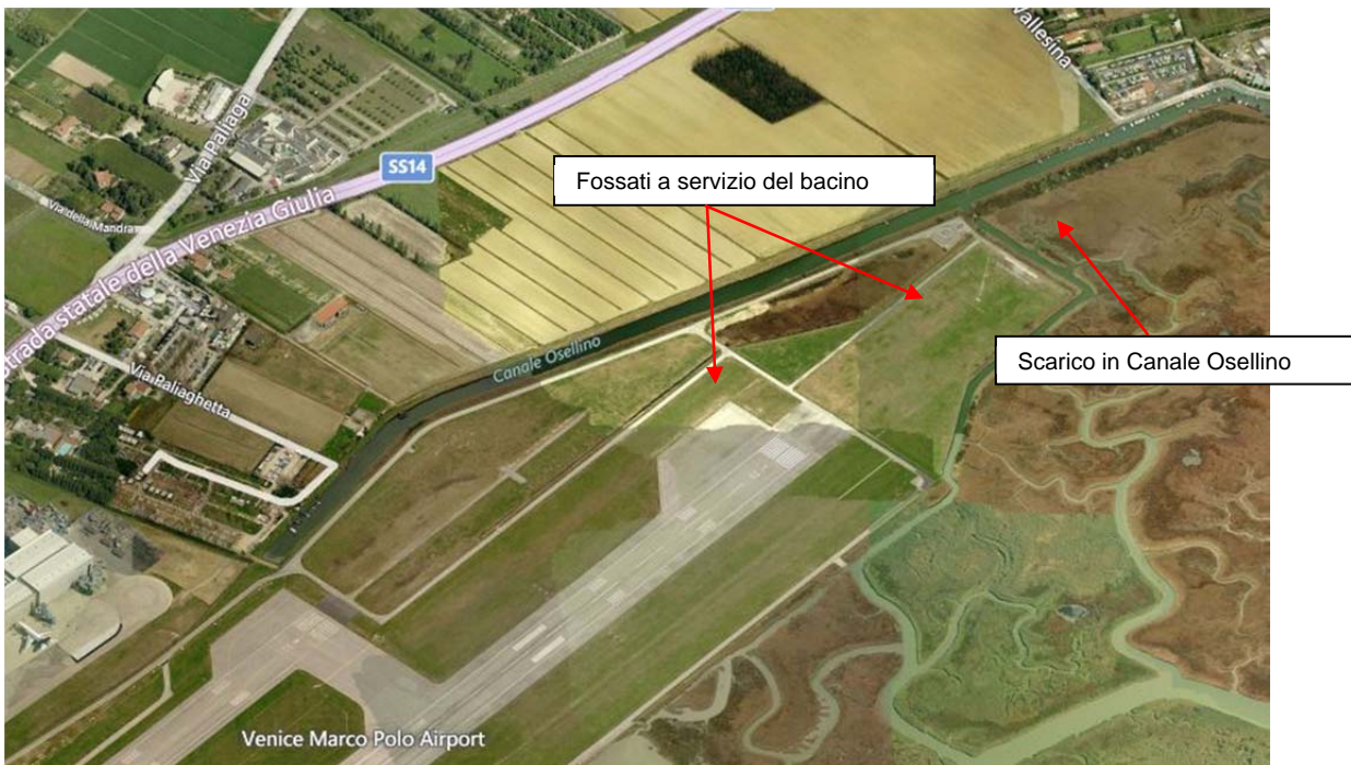
Figura 3-3 Aeroporto "Marco Polo" di Venezia: sottobacino scolante in laguna servito da collettori in c.a. chiusi e fossati a cielo aperto con scarico in canale Osellino, non servito allo stato attuale da impianti di trattamento.
