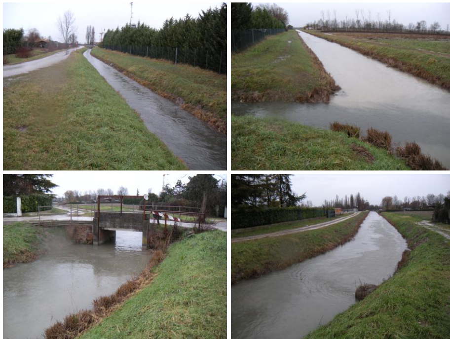
Figura 10. Sopra: vista verso monte del collettore Pagliagheta lungo via Ca'Rugger e della confluenza del Pagliagheta nel collettore Acque Medie Cattal. Sotto: viste verso valle del Collettore Acque Medie in prossimità della confluenza.
