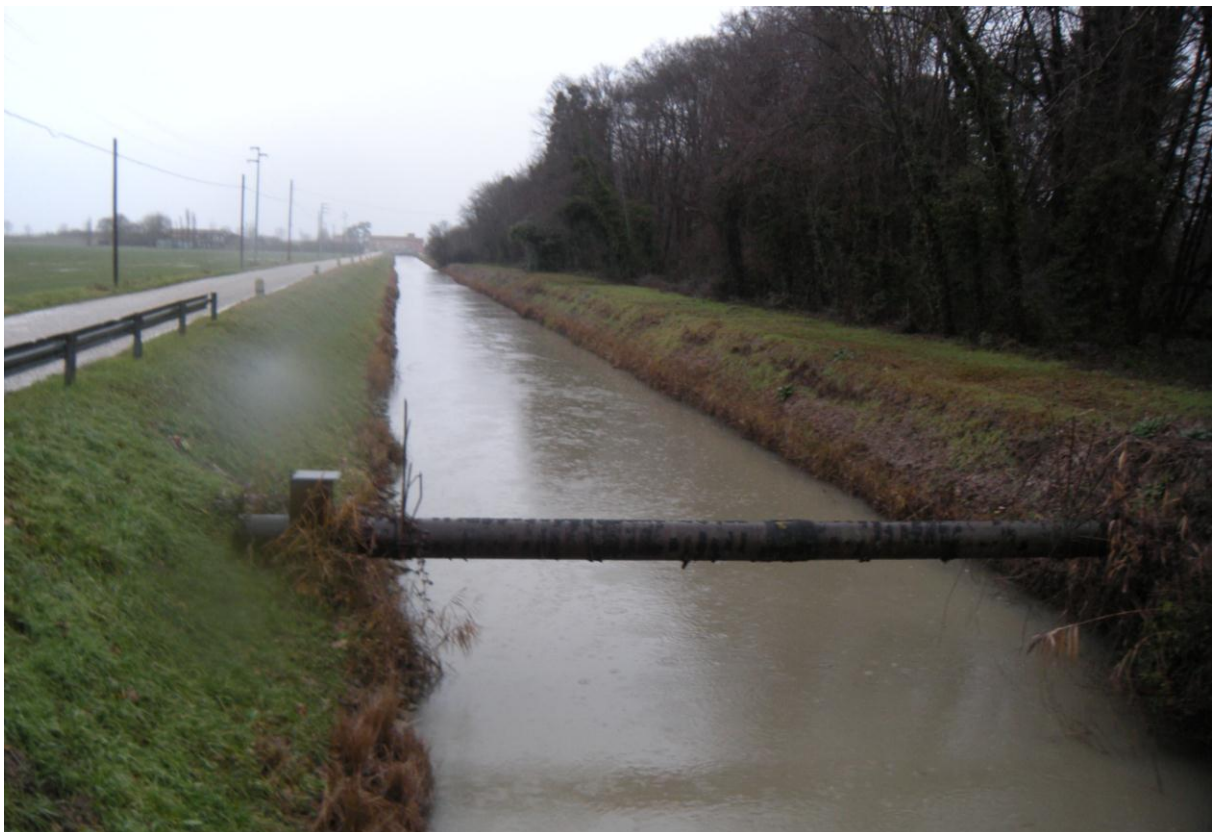
Figura 5. Vista da monte del collettore delle Acque Medie Cattal, in direzione dell'idrovora.
