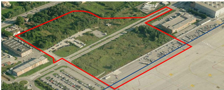
Figura 19. Area di intervento dell'ampliamento piazzali. In blu, il tracciato del collettore Pagliaghetta, con deflusso da sudovest a nordest.
