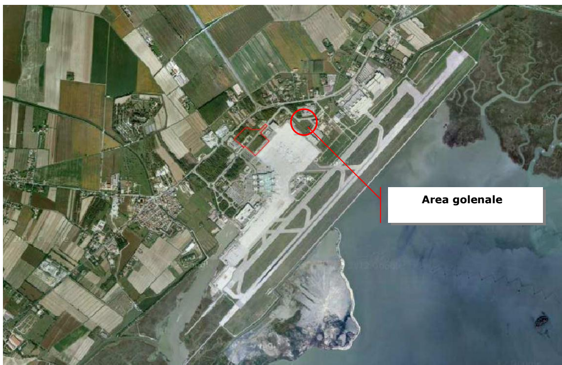
Figura 20. Inquadramento delle aree oggetto di intervento
