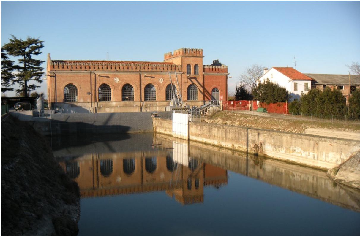
Figura 4. Vista da monte dell'idrovora Cattal. A sinistra il mandracchio del comparto delle acque basse, mentre il collettore delle acque medie raggiunge l'idrovora dietro al muro in primo piano.
