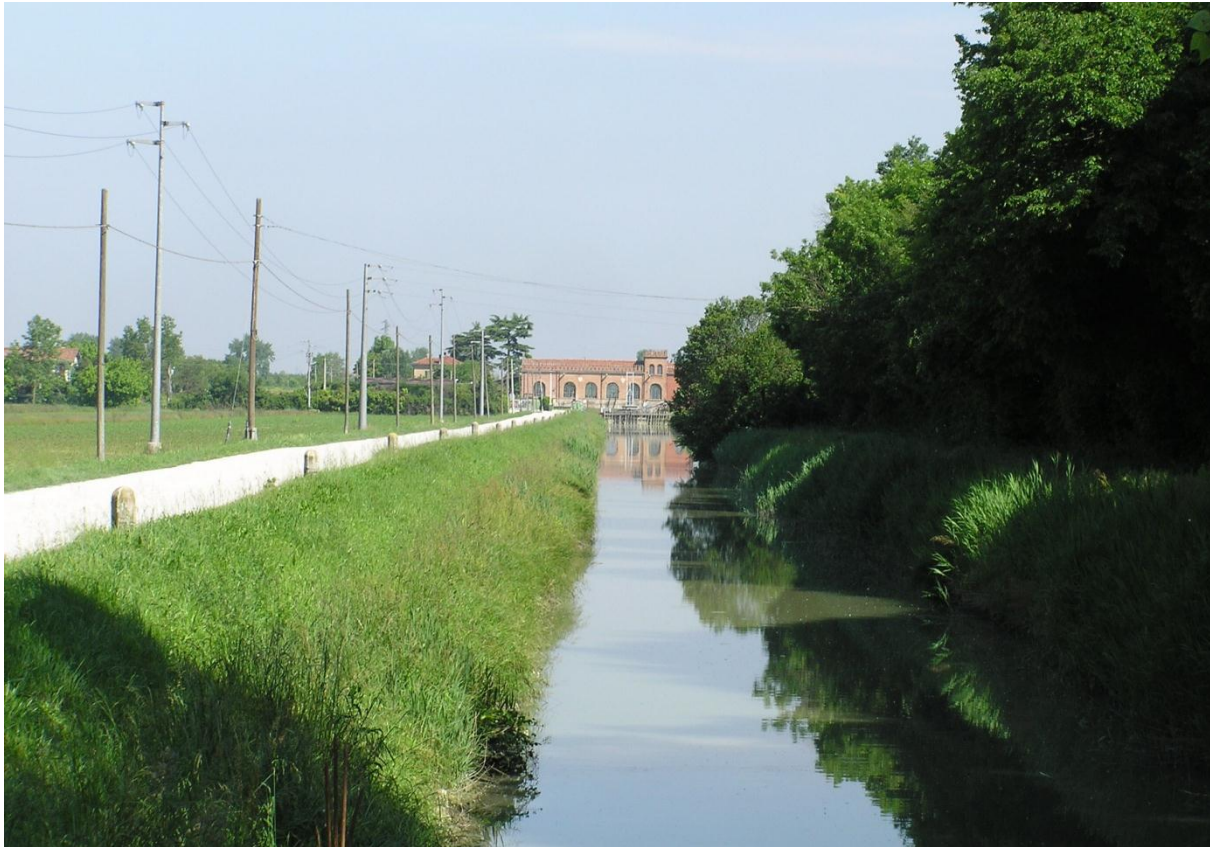
Figura 2.3. Vista da monte del collettore delle Acque Medie Cattal, in direzione dell'idrovora.
