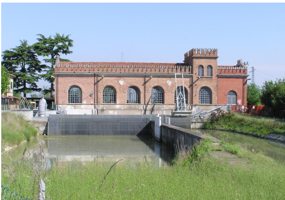
Figura 2.2. Vista da monte dell'idrovora Cattal. A sinistra il mandracchio del comparto delle acque basse, mentre il collettore delle acque medie raggiunge l'idrovora dietro al muro in primo piano.
