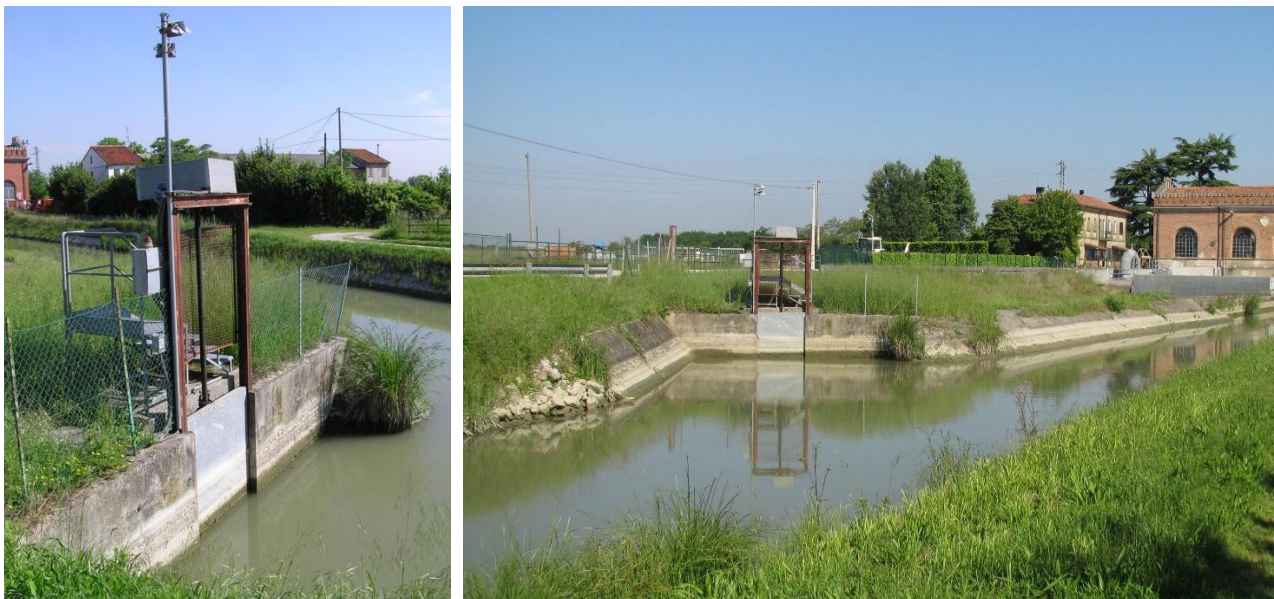
Figura 2.5. Vista della paratoia di collegamento delle Acque Medie Cattal con le Acque Basse Cattal in corrispondenza dell'idrovora Cattal.
