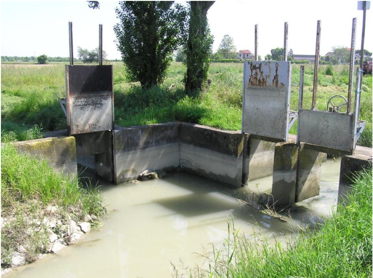
Figura 2.4. Manufatto partitore di portata posto lungo il collettore Acque Medie Cattal.
