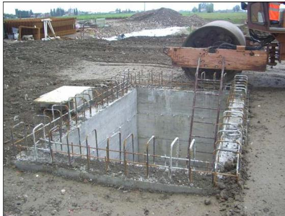
**Figura 2-5: cantina di perforazione (immagini di una postazione analoga)**
