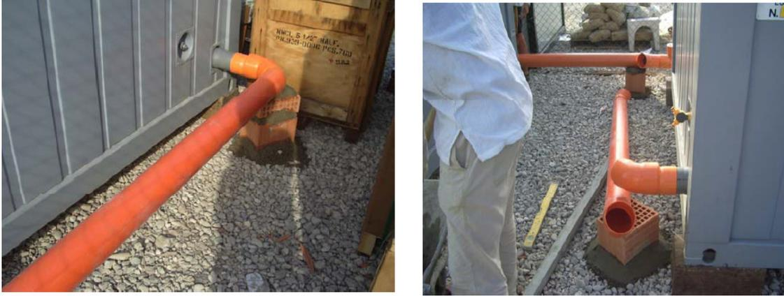
**Figura 2-11: Posa della rete di scarichi civili a disposizione degli operatori durante la perforazione (Immagini di una postazione analoga).**
