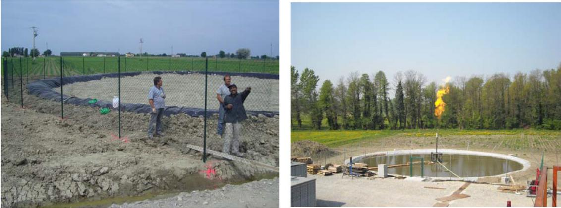
**Figura 2-10: Area fiaccola e la realizzazione della recinzione perimetrale (immagini di una postazione standard)**
