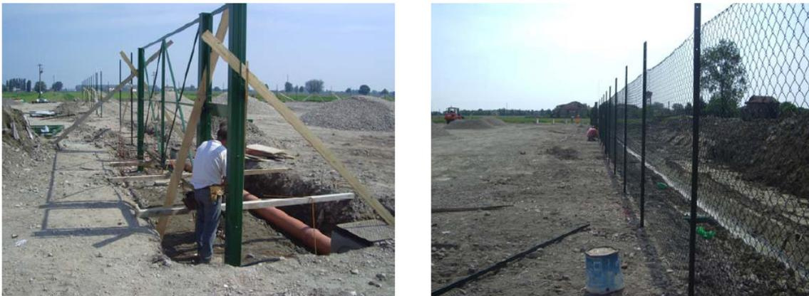
**Figura 2-3: Realizzazione della recinzione perimetrale (immagini di una postazione analoga)**
