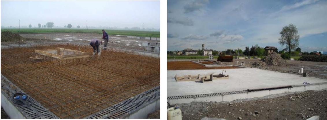
**Figura 2-6: preparazione della soletta in c.a. (immagini di una postazione analoga)**
