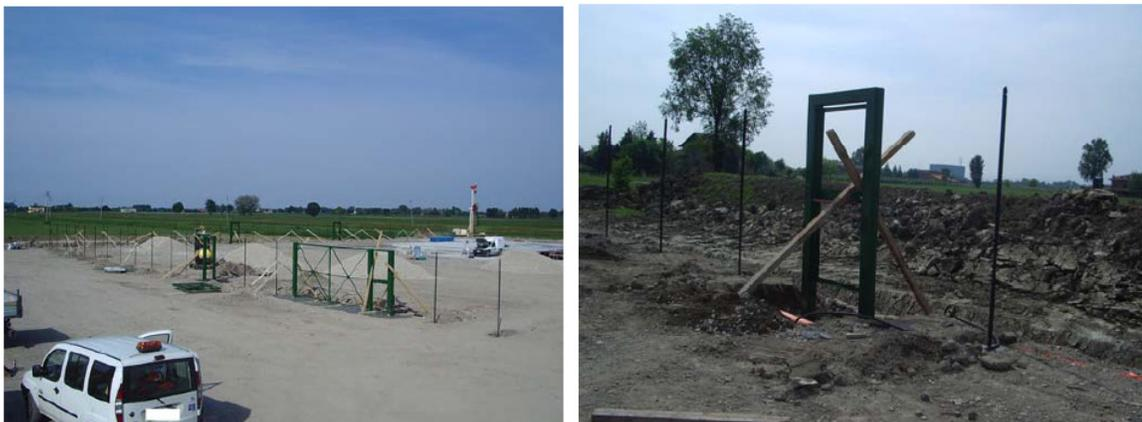
**Figura 2-4: Cannello carrabile con cancello pedonale annesso e posa di cancello per vie di fuga con maniglione antipanico (immagini di una postazione analoga)**
