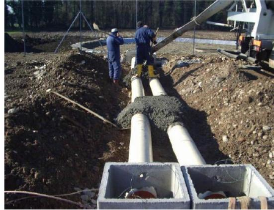
**Figura 2-9: cunicolo/canalizzazioni di contenimento del tubo del gasolio e canalizzazioni di passaggio cavi e/o condotte dell'impianto (immagini di una postazione analoga)**
