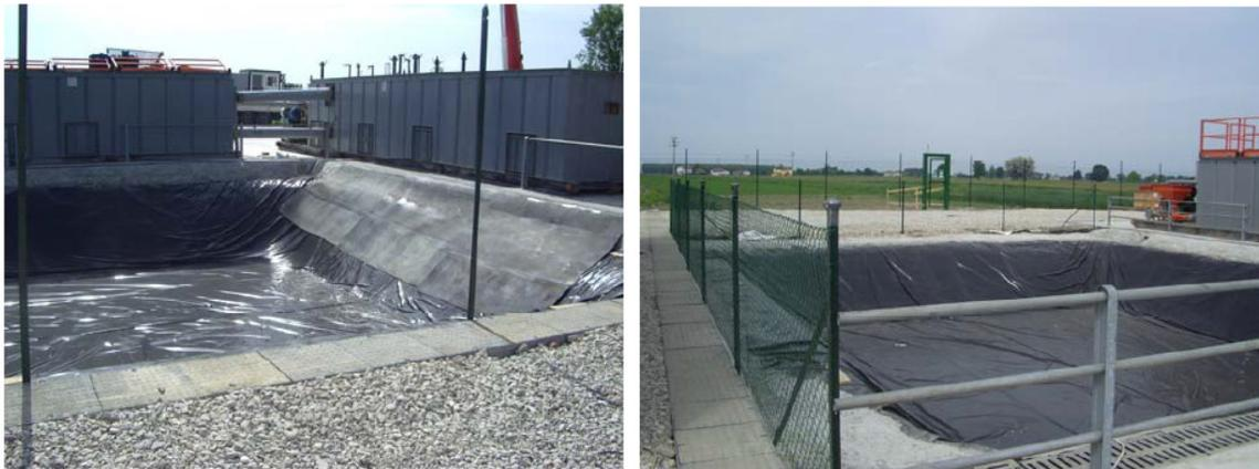
**Figura 2-8: Vasca di contenimento acqua, recinzione e parapetto di sicurezza laterali (immagini di una postazione analoga)**
