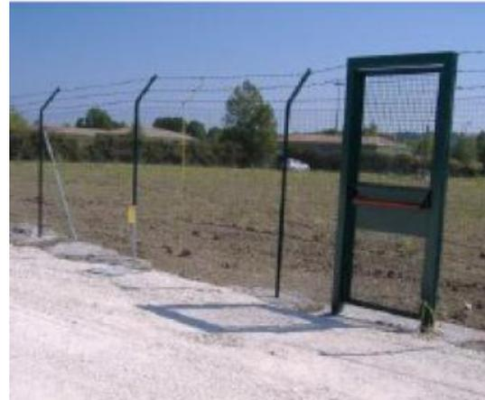
**Figura 3-6: esempio di recinzione della piazzola di perforazione, con le relative uscite di sicurezza**
