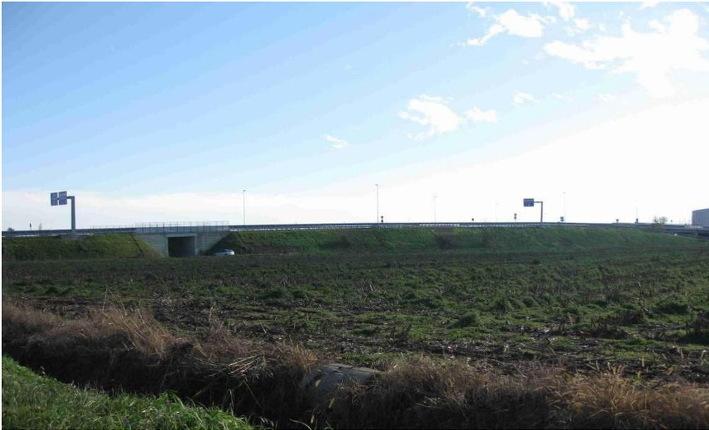
*Figura 13.2: Tangenziale SS231 accanto al tracciato della quale sarà posizionato il cavidotto*
