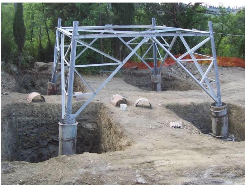
*Figura 13.3: Esempio di fondazione di un sostegno a traliccio*
