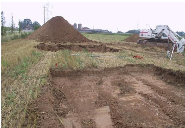
*Figura 13.4: Esempio di scotico terreno di un micro-cantiere*
