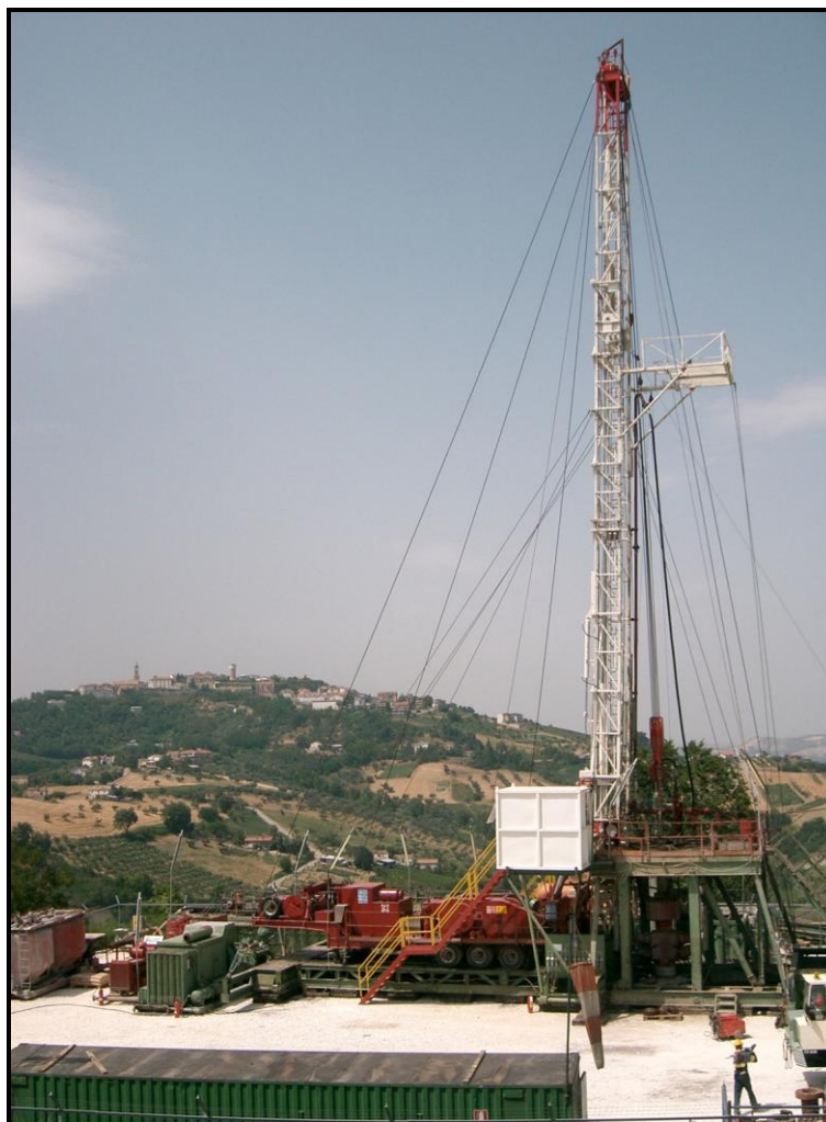
Figura 5.3a Esempio di Impianto di Perforazione con Potenzialità 1.500 m
