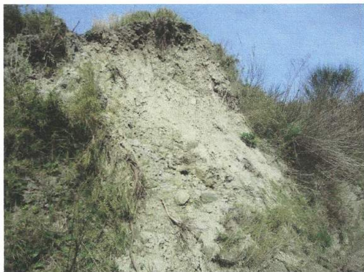
Fig. 11) dissesti presenti sulla parete occidentale dell'area2
