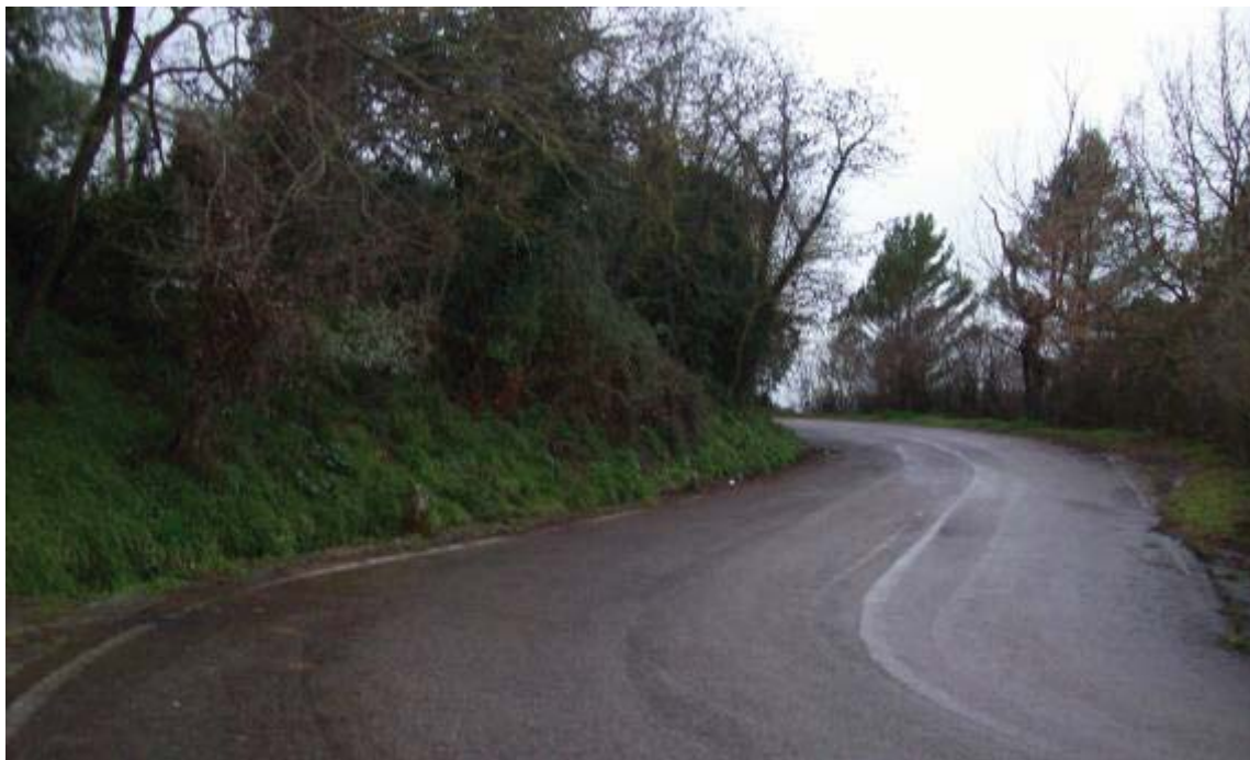
Foto 20. Area interessata dall'allargamento del tornante esistente con annessa costruzione di muro controripa: presenti pini, eucalipti, roverelle ed oleandri.
