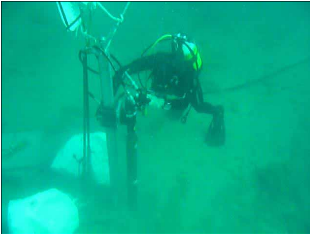
Figura 3.1 - Posizionamento della carotatrice sulla verticale di perforazione.
