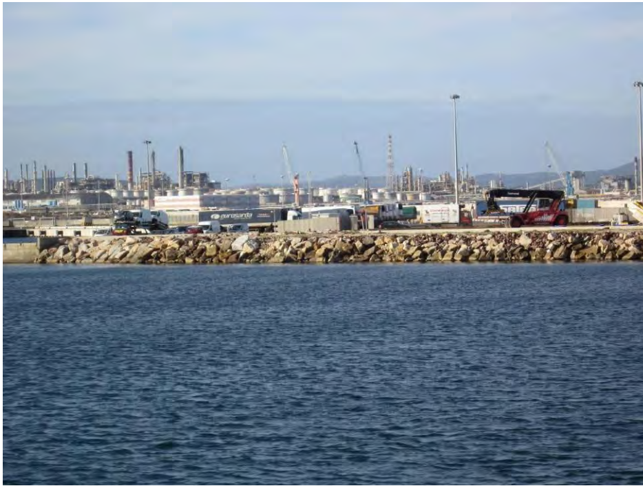
Figura 8-13: Vista del porto industriale
