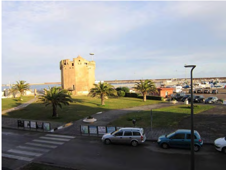
Figura 8-11: Vista del porto civico (da Porto Torres)
