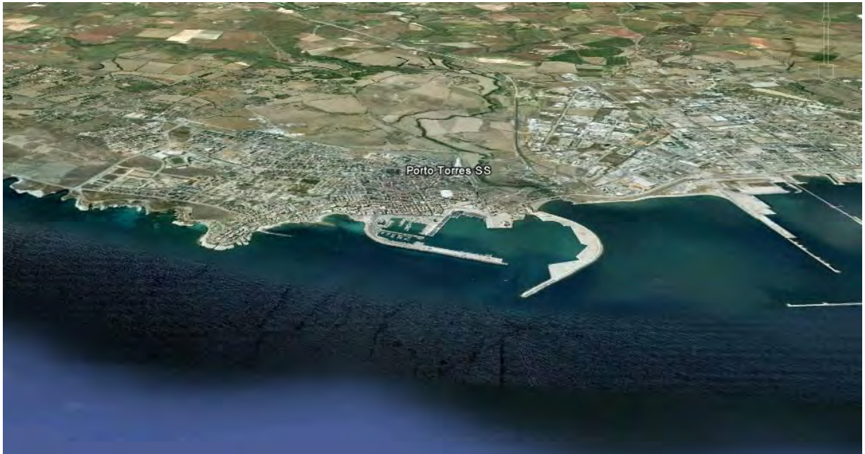
Figura 8-8: Vista aerea dell'area in studio (da Google Earth)
