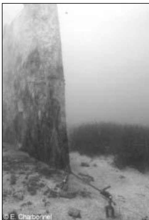
Figura 5-3: Uno schermo in geotessile (a sinistra) che protegge una prateria di Posidonia oceanica (a destra) in un lavoro sottomarino in Francia. (foto E. Charbonnel)
