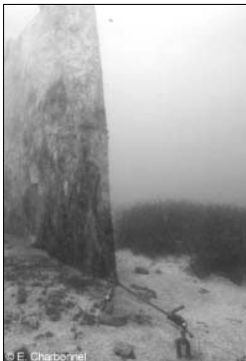
Figura 3-1: Uno schermo in geotessile (a sinistra) che protegge una prateria di Posidonia oceanica (a destra) in un lavoro sottomarino in Francia. (foto E. Charbonnel)
