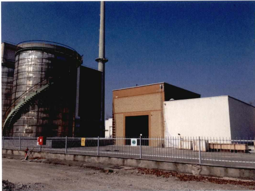
Foto 4 - edificio Test tank (lato sud)
