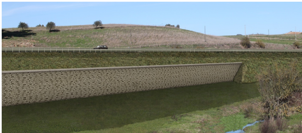
Fotosimulazione muro di contenimento su asse principale
