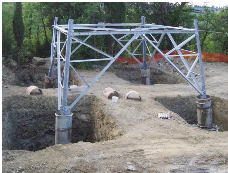
Figura 6.1 - Esempio di fondazione di un sostegno
