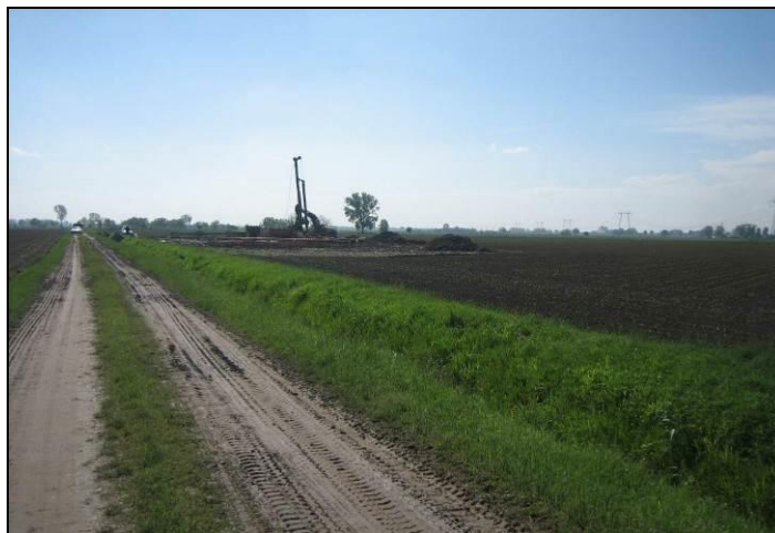
Figura 7.3 - Esempio di micro cantiere con annessa pista di accesso
