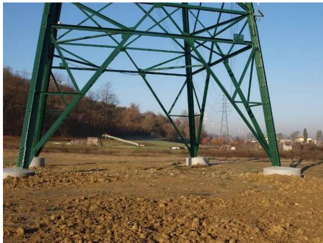
Figura 11.1 - Ricostituzione suolo agrario sulla superficie dismessa di un microcantiere
