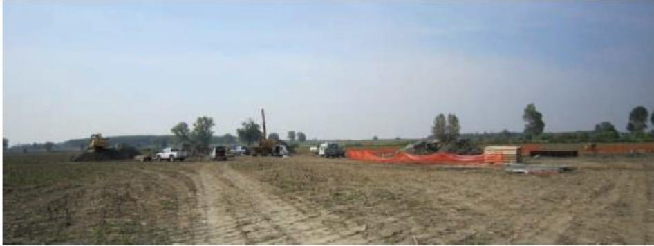
Figura 7.6 – Esempio di microcantiere e relativa pista di accesso
