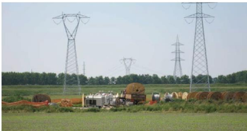
Figura 7.9 – Esempio di cantiere lineare per la tesatura dei conduttori
