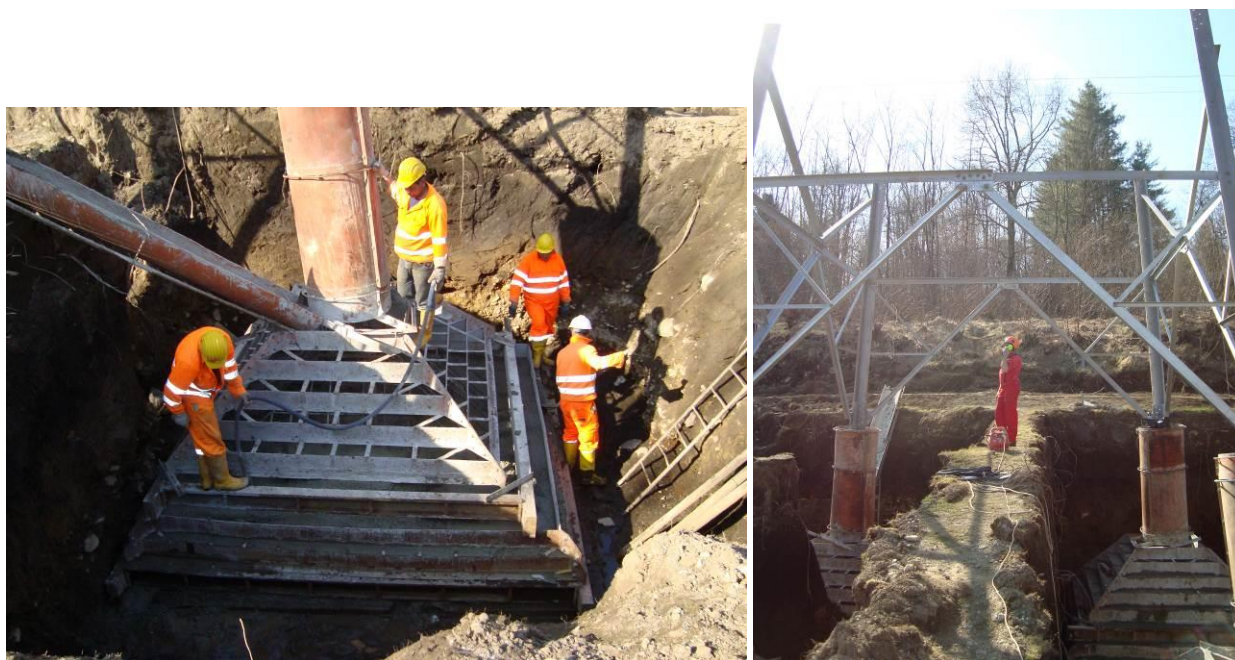
Figura 6.2 - Esempio di realizzazione del piede di fondazione
