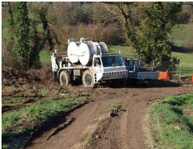
Figura 6.3 - Postazione di lavoro per tesatura conduttori e per la stesura della corda pilota
