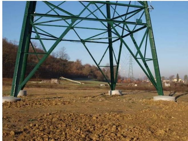
Figura 8.1 - Ricostituzione suolo agrario sulla superficie dismessa di un microcantiere
