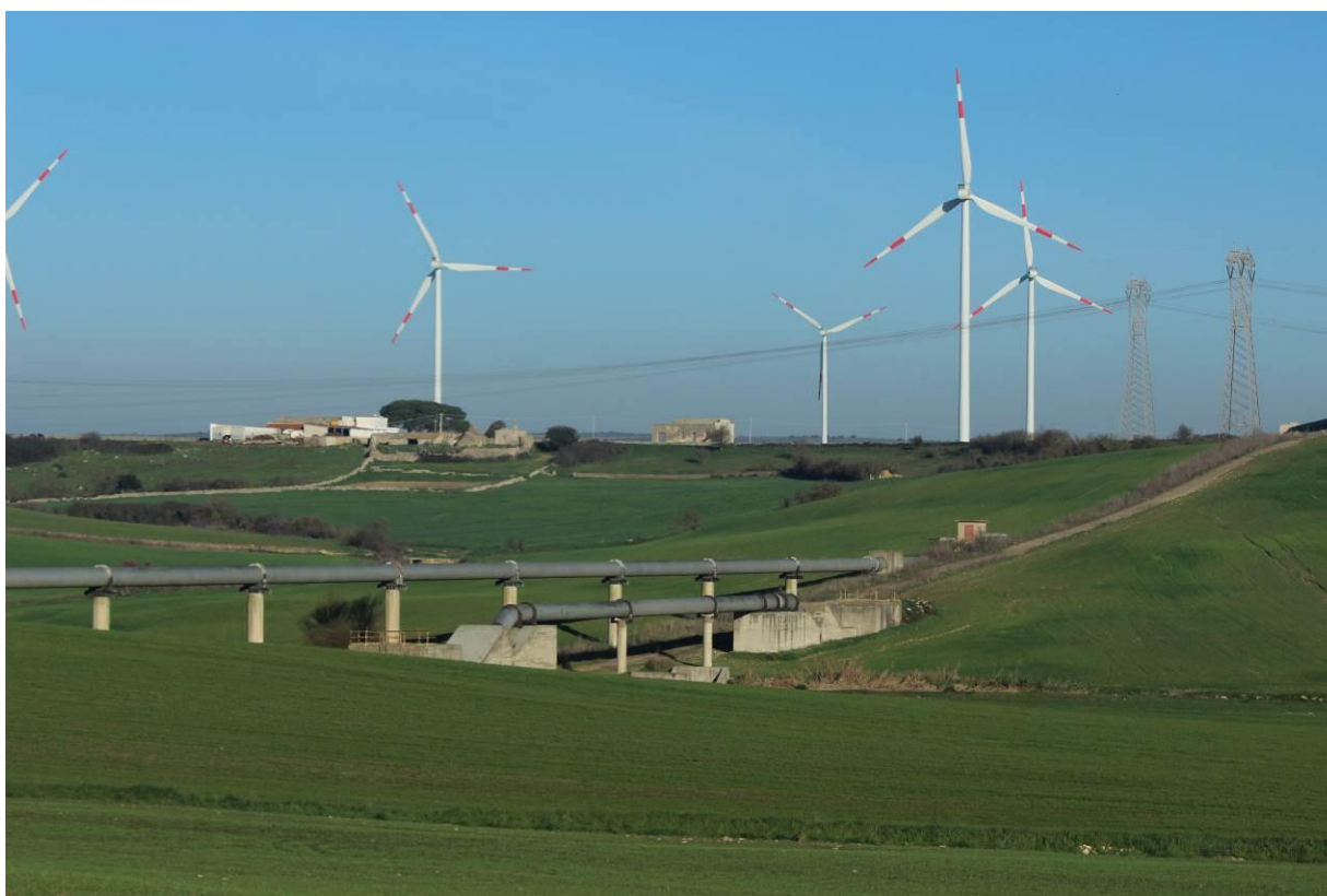
Figura 3.7 - Area del parco eolico ed in primo piano il gasdotto
