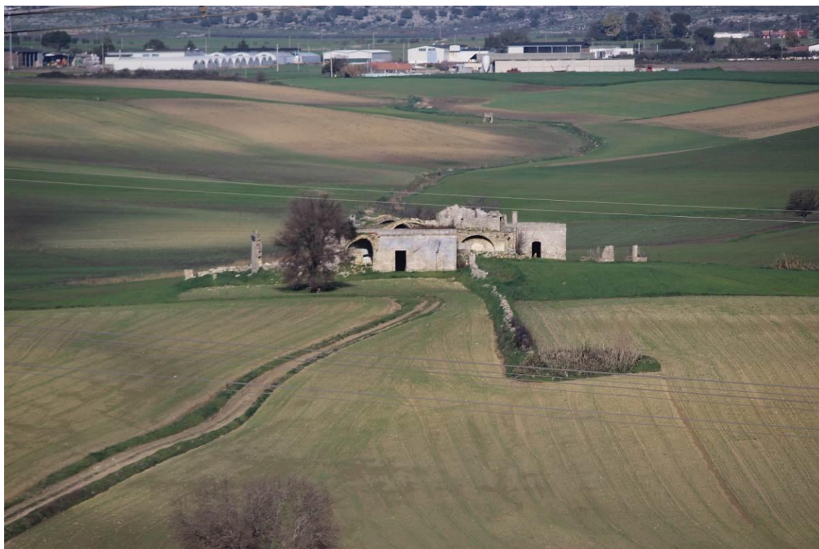
Figura 3.6 - Esempio di masseria, in stato di abbandono, presente nel territorio in esame
