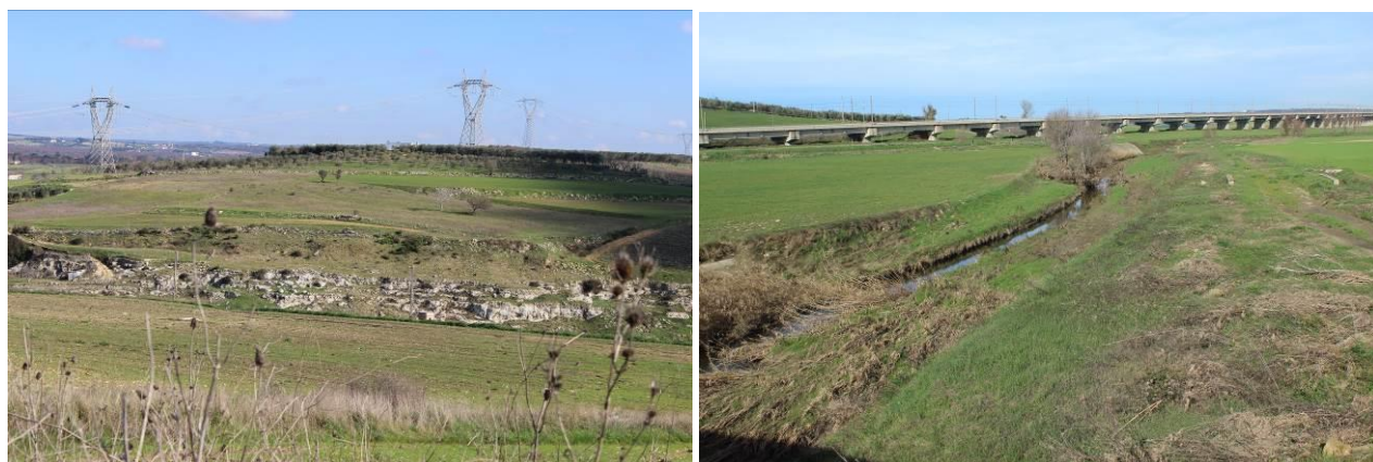
Figura 6.7 – Differente risalto morfologico dell'incisione idrografica della gravina di Castellaneta nella zona di attraversamento (dx) e subito a nord del ponte sulla SP23 (dx)
