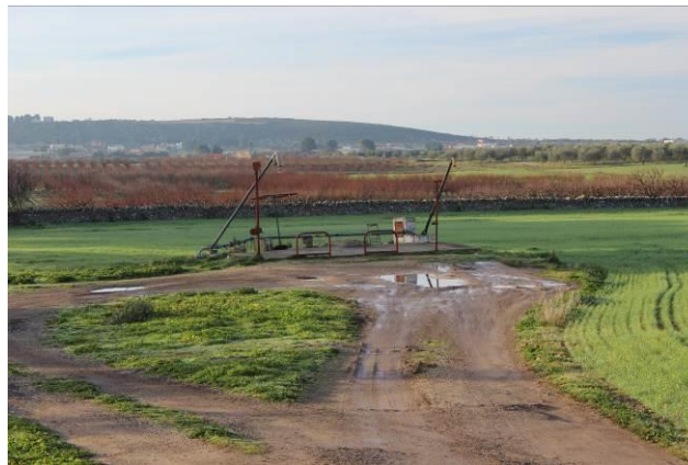
Figura 8.10 – Stazione per ricarica cisterne alimentata da pozzo profondo nell'area tra i sostegni S43 e
