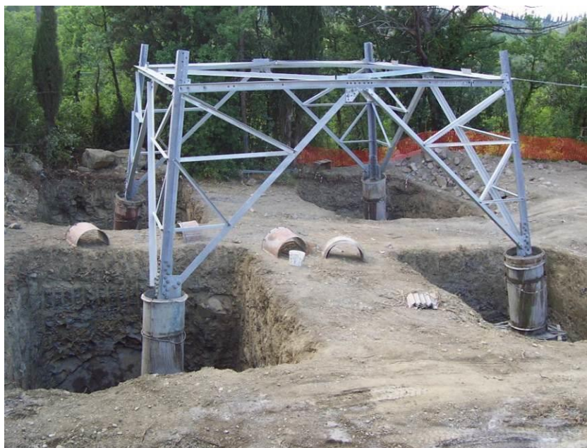
Figura 10.1 - Esempio di fondazione di un sostegno
