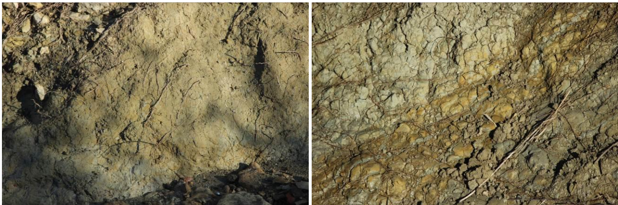
Figura 5.7 – Affioramento delle alluvioni nella zona sottostante la campata S10-S11
