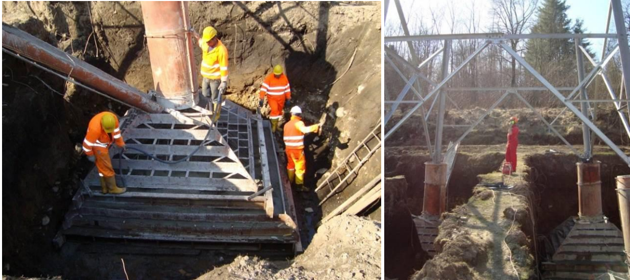
Figura 10.2 - Esempio di realizzazione del piede di fondazione
