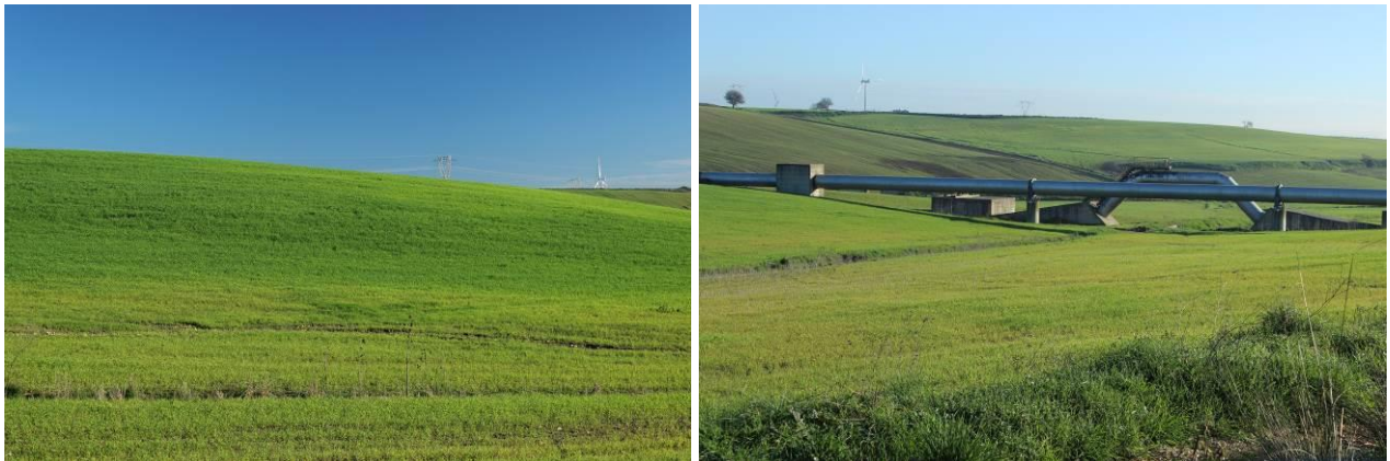
Figura 5.2 – I pendii argillosi nell'area dei sostegni S4 (sx) e S5 (dx)
