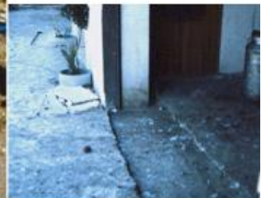
Figura 10: Fagliazione fino in superficie dei sedimenti sciolti (con fenomeni di liquefazione) nella Piana del Dragone nel Comune di Volturara Irpina. Le fratture hanno tranciato il tubo dell'acquedotto.
