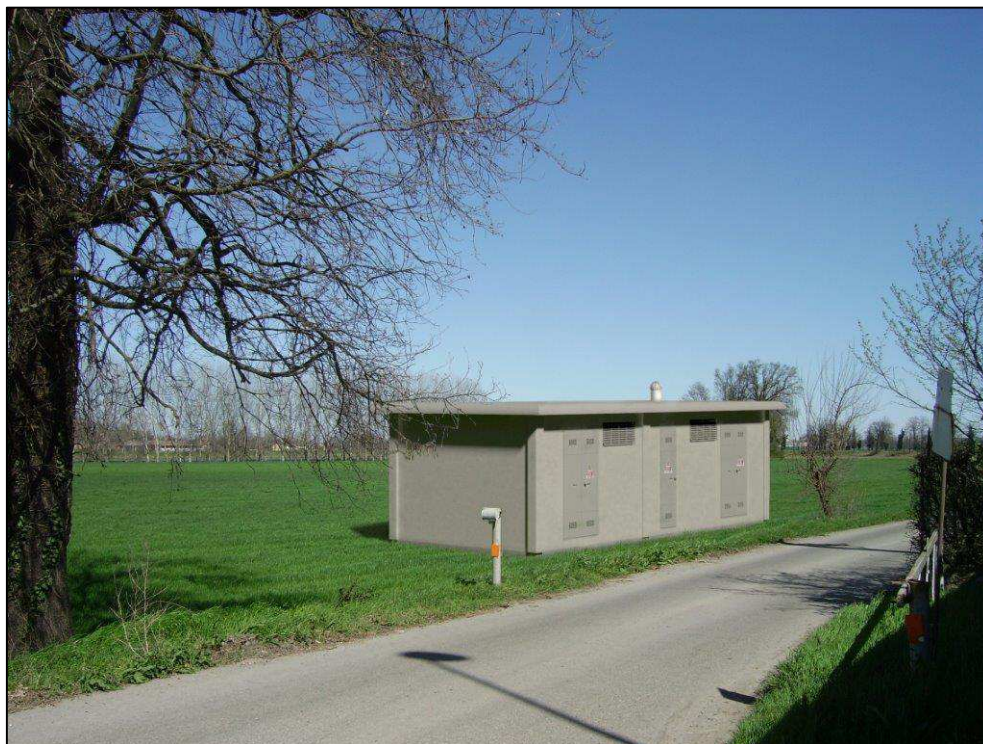
Figura 29: Foto inserimento della nuova cabina elettrica
