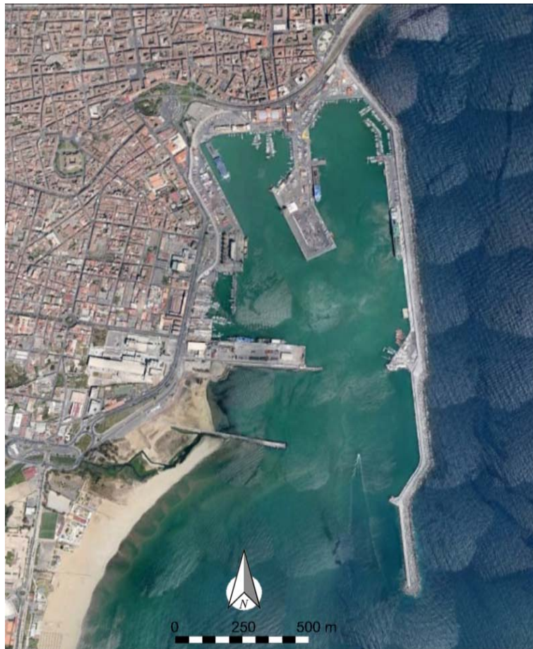
Figura 4.2 Vista satellitare del porto di Catania.
