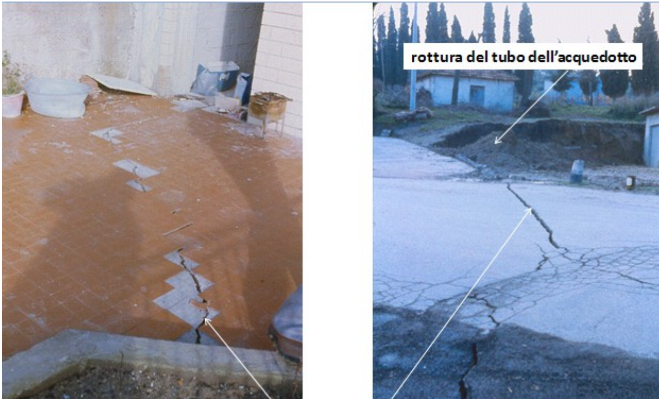
Fig. 33 - Spostamenti verticali tra blocchi contigui con differenti caratteristiche geomeccaniche rilevati in tutta l'area epicentrale.
