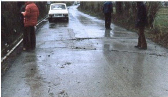
Fig. 31 - Fagliazione fino in superficie dei sedimenti sciolti (con fenomeni di liquefazione) nella Piana del Dragone nel Comune di Volturara Irpina. Le fratture hanno tranciato il tubo dell'acquedotto.
