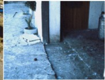
Fig. 31 - Fagliazione fino in superficie dei sedimenti sciolti (con fenomeni di liquefazione) nella Piana del Dragone nel Comune di Volturara Irpina. Le fratture hanno tranciato il tubo dell'acquedotto.
