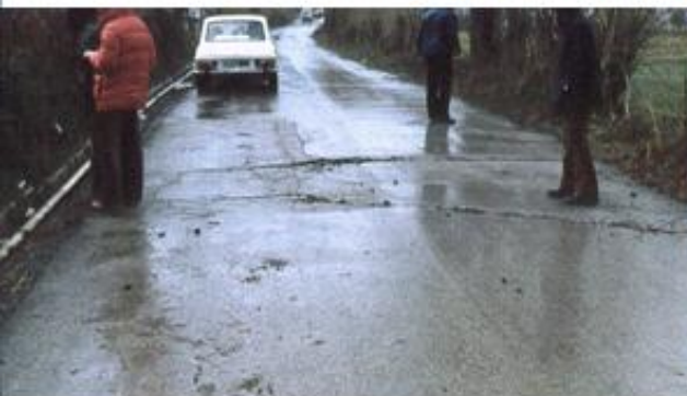
Figura 10: Fagliazione fino in superficie dei sedimenti sciolti (con fenomeni di liquefazione) nella Piana del Dragone nel Comune di Volturara Irpina. Le fratture hanno tranciato il tubo dell'acquedotto.
