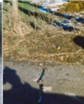
Figura 10: Fagliazione fino in superficie dei sedimenti sciolti (con fenomeni di liquefazione) nella Piana del Dragone nel Comune di Volturara Irpina. Le fratture hanno tranciato il tubo dell'acquedotto.
