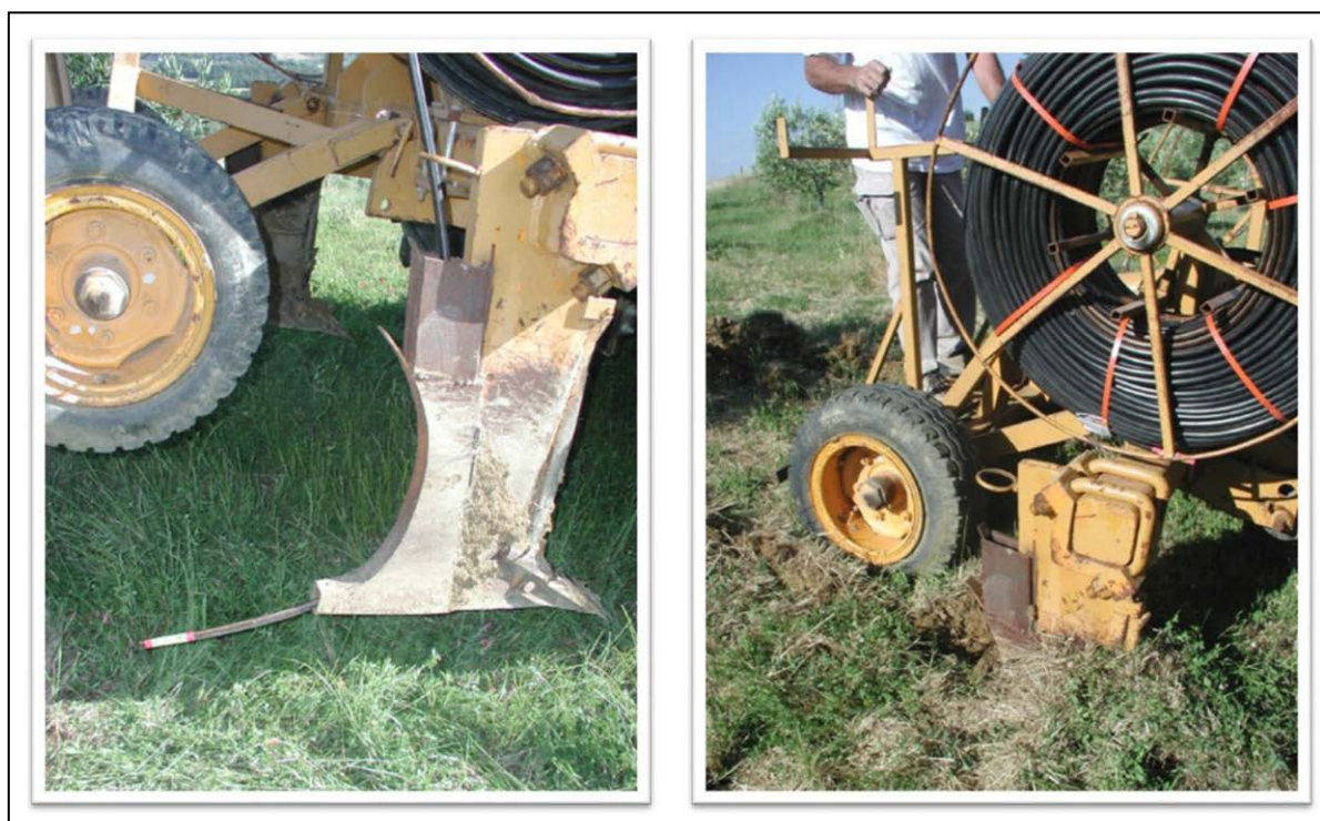
Figura 27: Particolare della macchina per l'interramento
