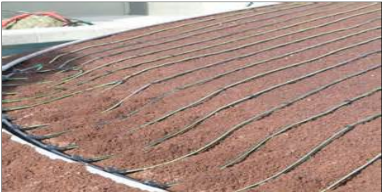
Figura 3: Impianto di subirrigazione in costruzione
