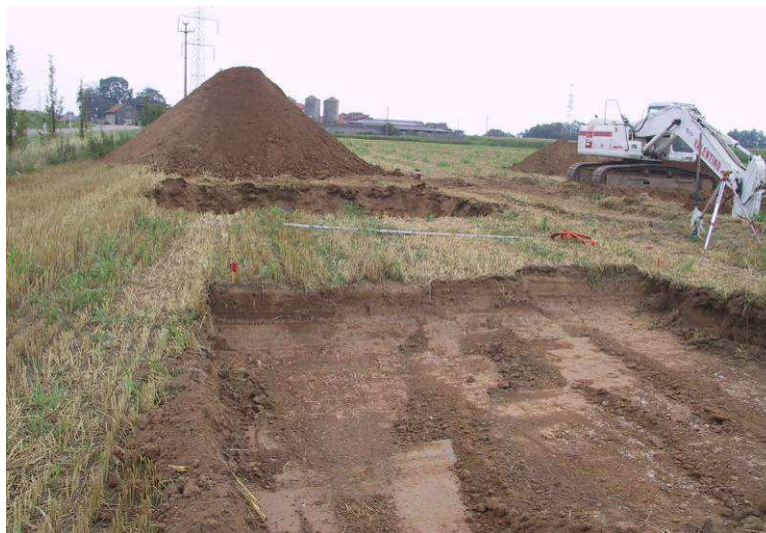
Figura 9-3 Esempio di scotico terreno di un micro-cantiere
