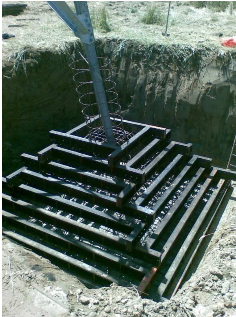
Figura 7-2 - Esempio di realizzazione del piede di fondazione
