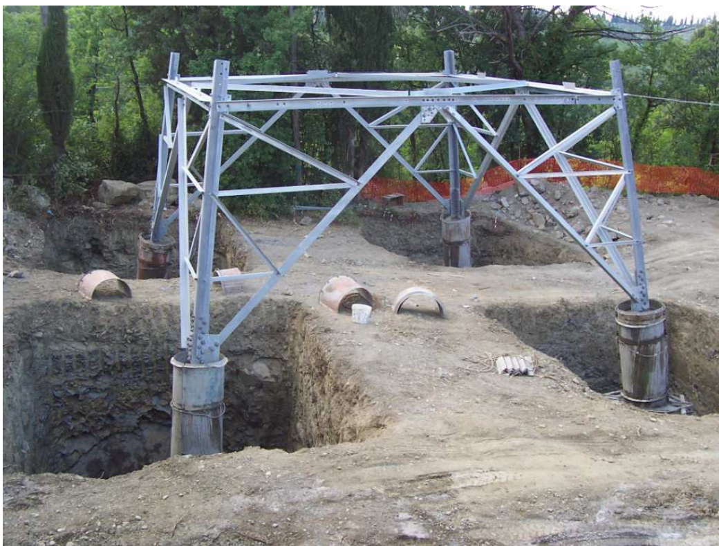
Figura 7-1 - Esempio di fondazione di un sostegno
