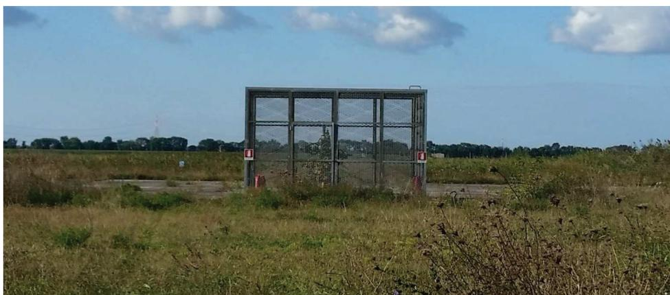
**Figura 4—3 Ripresa fotografica Area Pozzo Agosta 1 dir - particolare della testa pozzo protetta da gabbionatura**
