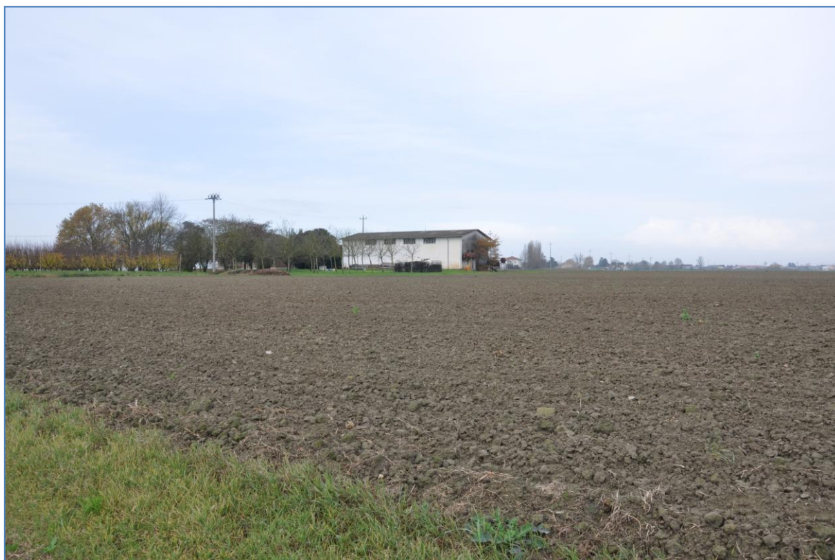
Foto 18: Edificio 5 annesso produttivo (d = 540 m; 600 m l'edificio abitato), Possessione Palazzina (Ril. 0042)
