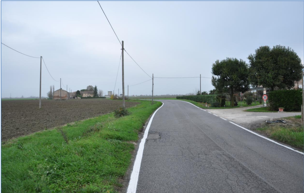
Foto 6: La zona di accesso al cantiere lungo la Via Ruffetta (Ril. 0121)
