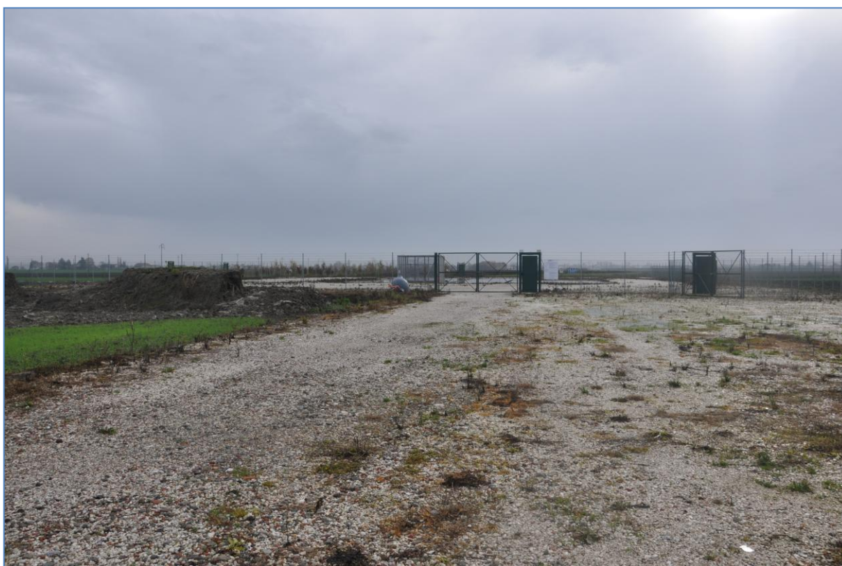
Foto 1E: L'area di intervento (Ril. 0014)
