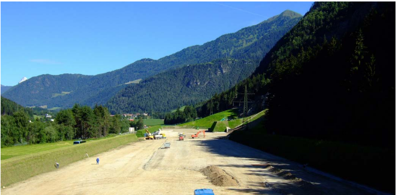
Abbildung 33: Bereits errichtete Erdwälle beim Baustellenbereich in Mauls
