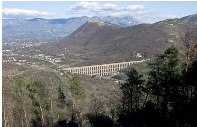
Figura 12 – Acquedotto Carolino Sito Unesco – Caserta
