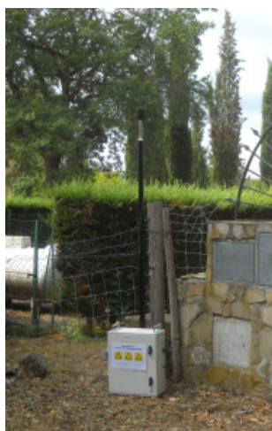
Fig. 5: Stazione di misura 02 (43°23'21" N. 10°43'40" E)
