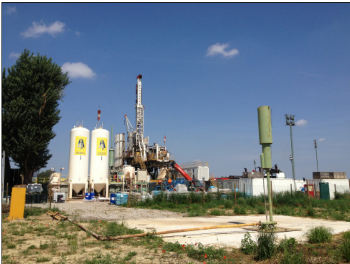
Figura 1: Vista d'insieme della piazzola
