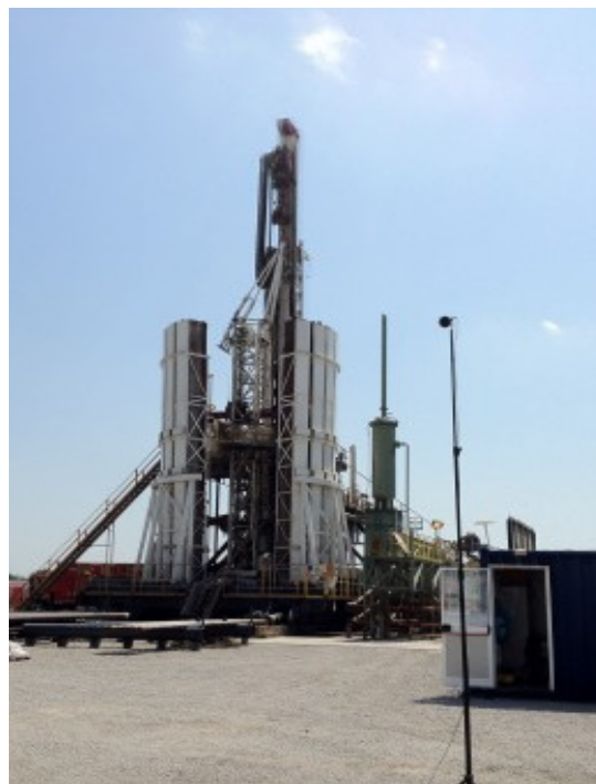
P6 (Lato SudOvest)
