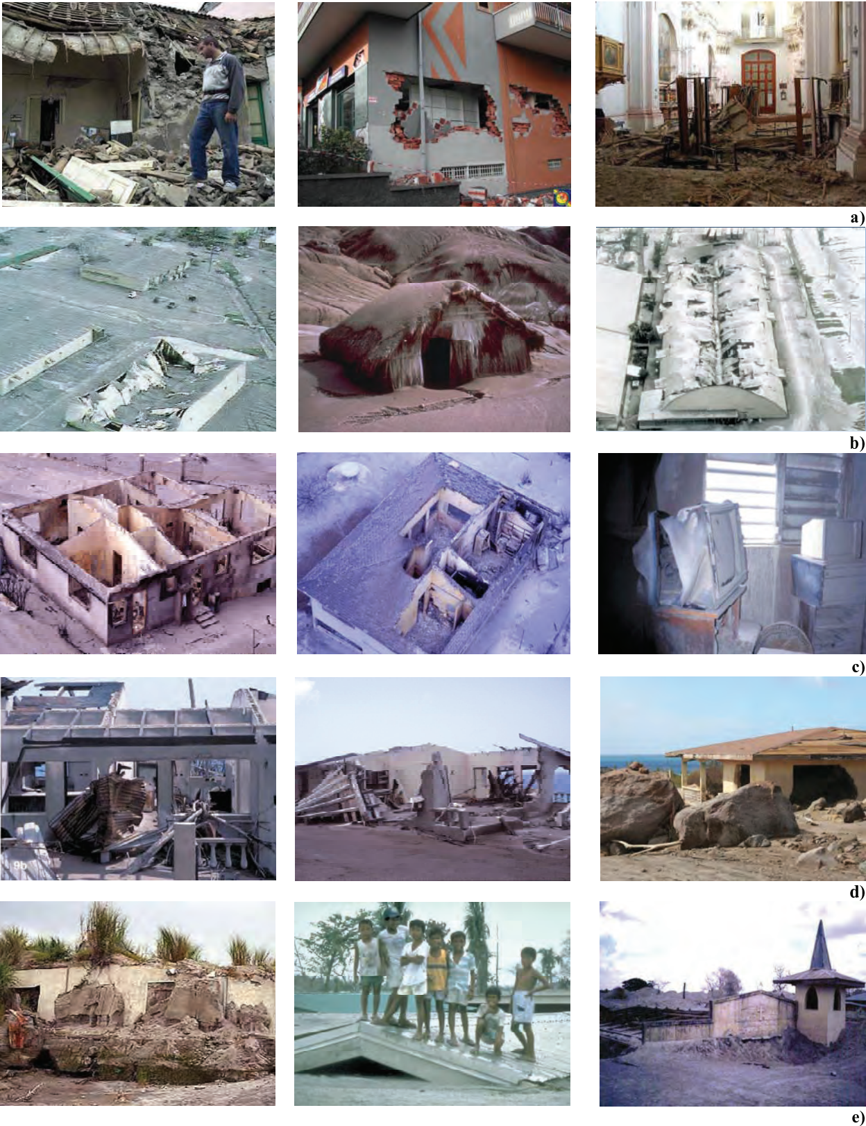
Figura 8.1.1. Danni alle costruzioni prodotti dai diversi fenomeni generati da un'eruzione vulcanica. a) terremoto: 2002, Santa Venerina, vulcano Etna, Italia; b) ricaduta di ceneri: 1991, vulcano Pinatubo, Filippine; c) flussi piroclastici: 1997, vulcano Soufrière Hills , Montserrat, Caraibi, UK; d) ricaduta di balistici e missili: 1997, vulcano Soufrière Hills , Montserrat, Caraibi, UK ; e) lahars: 1991, vulcano Pinatubo , Filippine.
