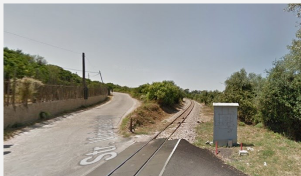
Figura 5-18 Foto dalla Strada Vicinale Ungias nel punto in cui il tracciato stradale, al Km 3+645 (2 a Tratta), si interseca con la linea ferroviaria Sassari - Alghero stradale (fonte Google Earth)
