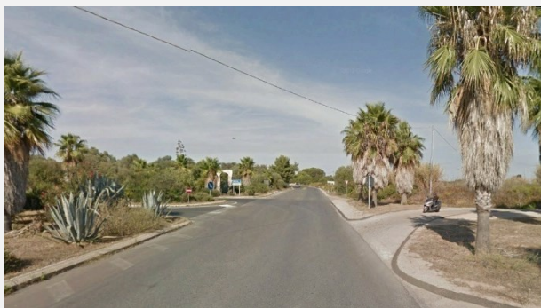
Figura 5-17 Foto dalla SP 42 in direzione dell'incrocio a sinistra con la SS 291 dir e a destra il punto in cui inizia l'intervento del nuovo tracciato stradale (fonte Google Earth)
