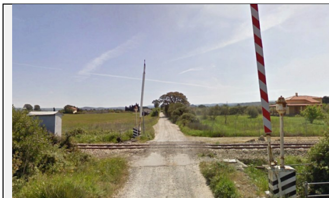
Figura 6-11 Visuale del punto di intersezione tra la Strada Vicinale Salto Don Peppino con il nuovo asse stradale, in corrispondenza del Km 1+530 circa, che si sviluppa parallelo alla ferrovia.
