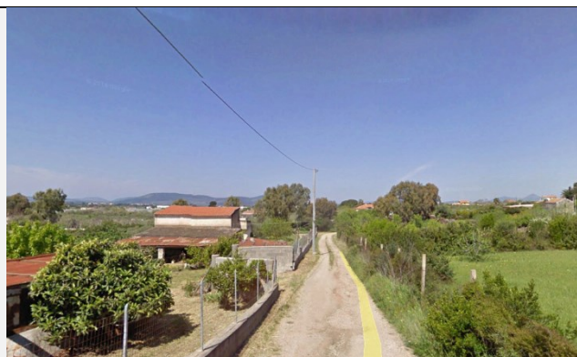
Figura 6-12 Visuale del punto di intersezione tra Strada Vicinale Poneddu Puntet e il nuovo asse stradale in corrispondenza del Km 2+730 circa.
