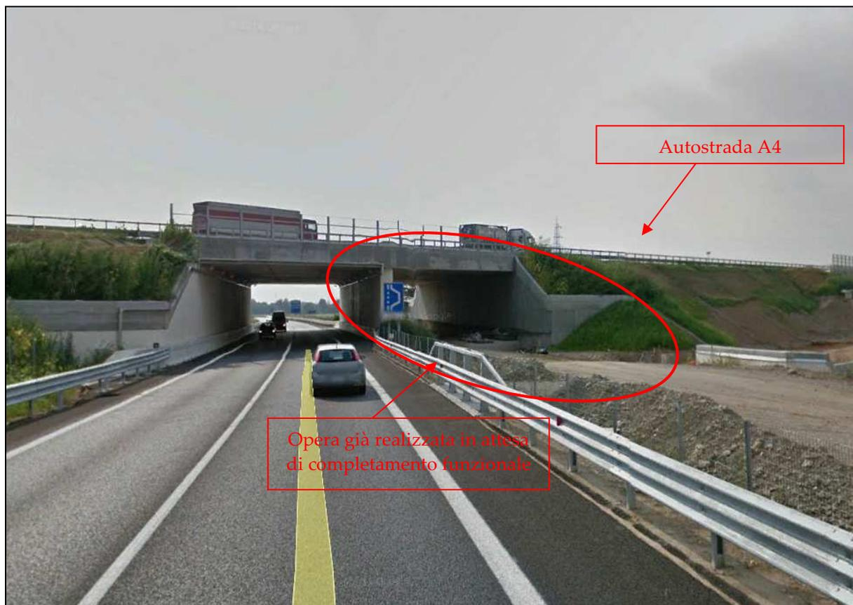
Figura 4.1-15 – Galleria artificiale sottopasso A4 già realizzato (SL67) in attesa di completamento funzionale (vista da Est)
