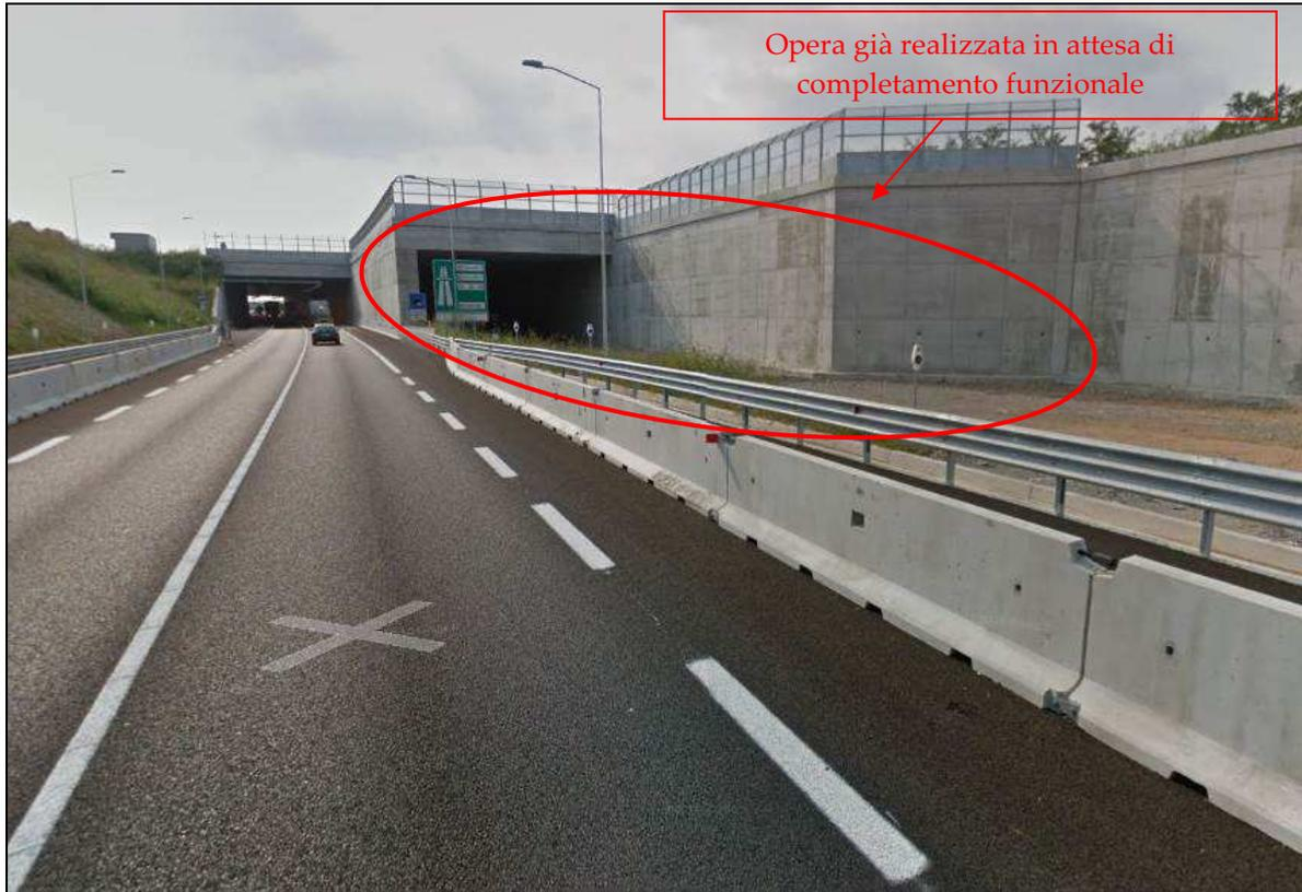
Figura 4.1-9 - Opera già realizzata WBS GAA02 – Galleria artificiale di Lovornato - In attesa di completamento funzionale(vista da Est)
