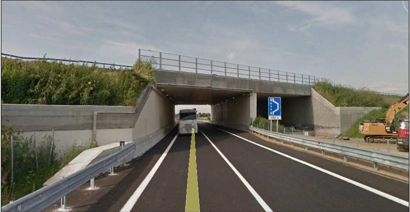
Figura 4.1-8 – Galleria artificiale a doppio fornice che viene sfruttata per il passaggio di uno dei rami dell'interconnessione e della bretella di collegamento con la tangenziale di Brescia.
