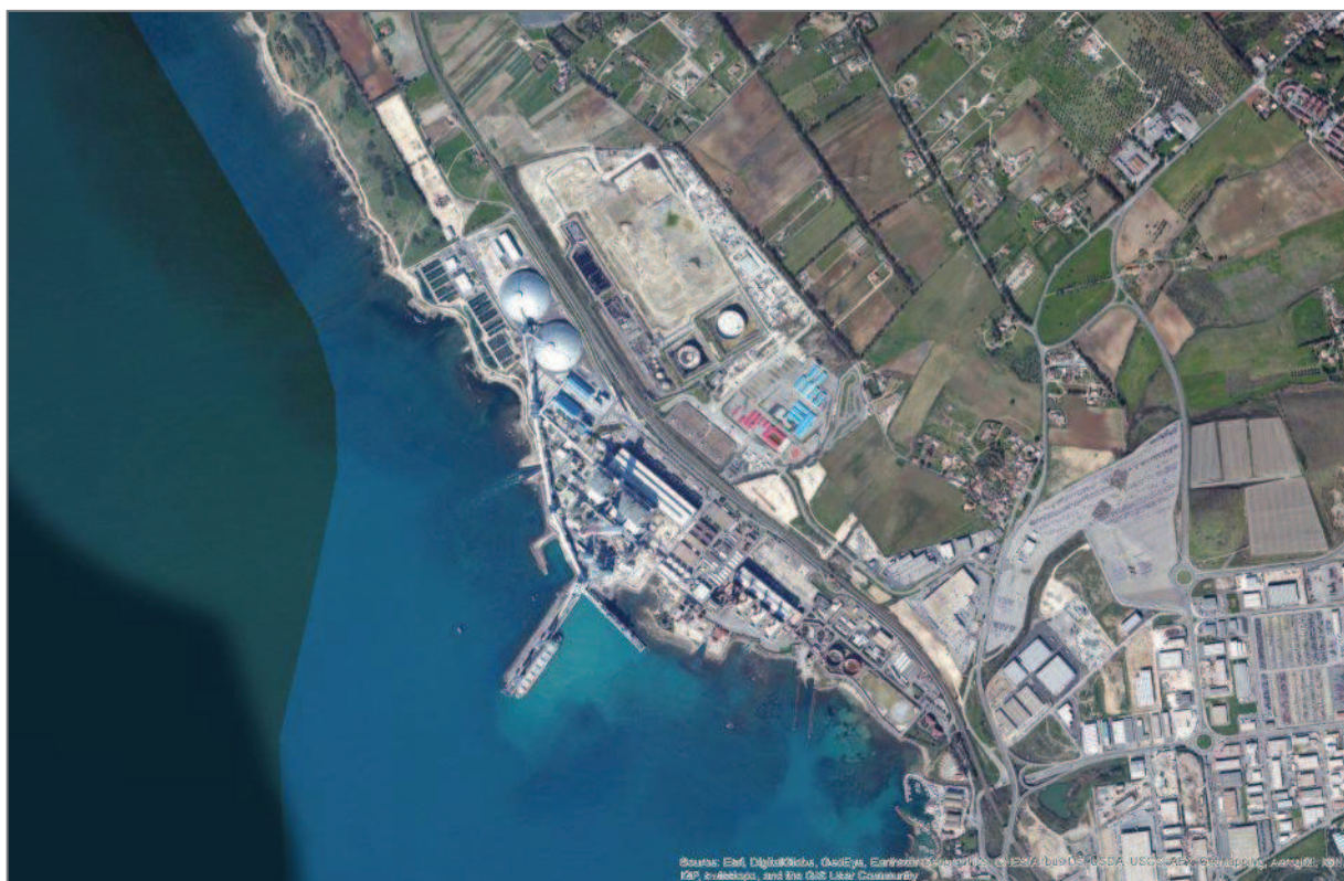
Figura 1.3.2 – Ubicazione Centrale Torrevaldaliga Nord (Fonte: World Imagery, ESRI. Agosto 2011)
