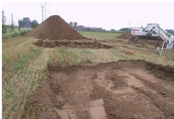
*Figura 2.5-1 - Esempio di fase di tracciamento e scotico terreno di un micro-cantiere*
